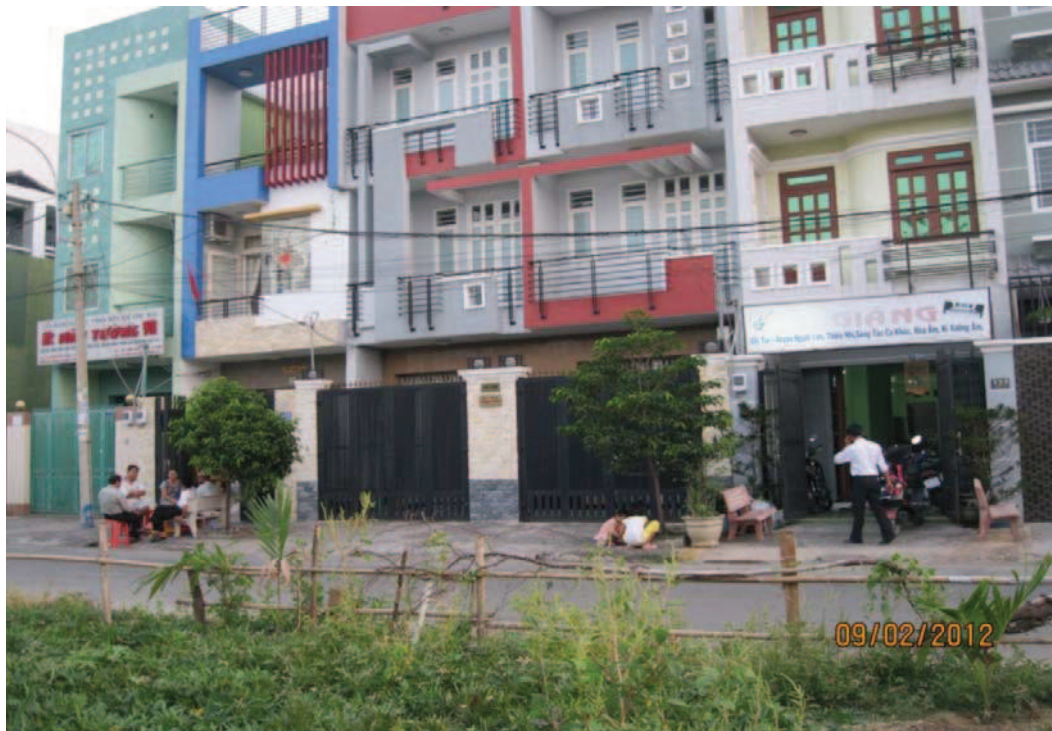
Image 44: les pas de portes des nouveaux propriétaires au moment de la sortie du travail
