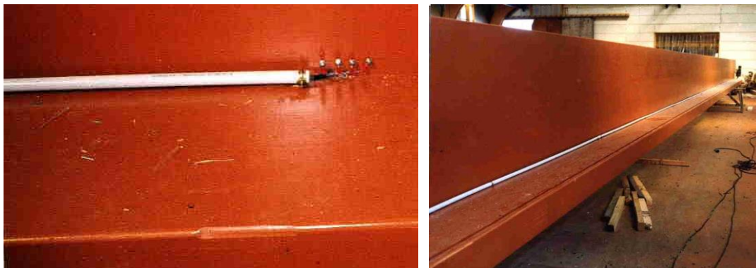
Sondes hydriques mises en place en atelier (Pont de Merle)
