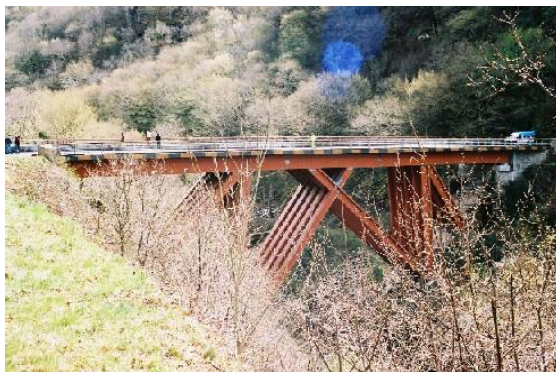
Pont Routier de Merle (19)
