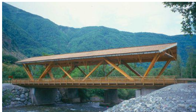
Pont Routier des Fayettees à Valbonnais (38)
