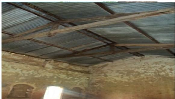
(e) Toiture partie centrale (charpente métallique + tôle ondulée)
