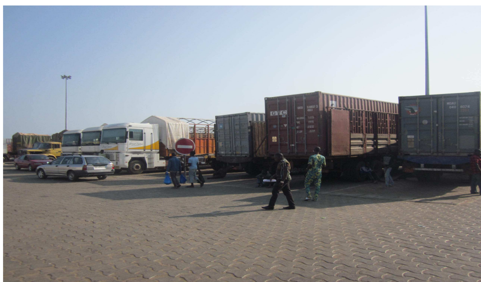
Photo 4: Parking gros porteurs d'une capacité de 250 camions construit par le MCA
