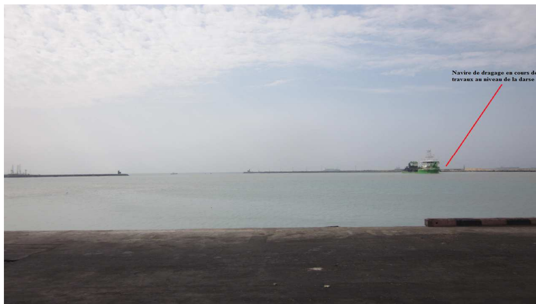
Photo 11: Dragage en cours pour la construction de la darse MSC
