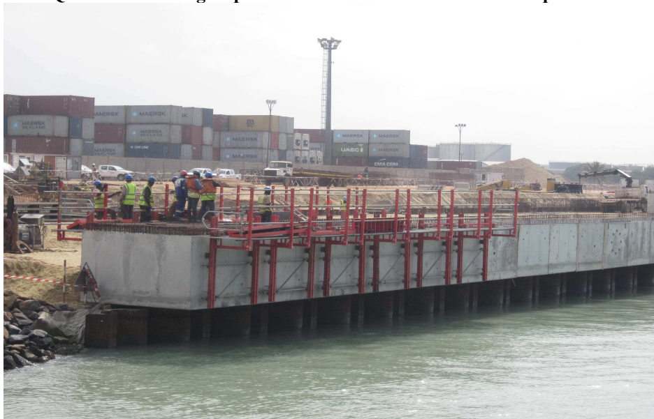
Photo 10: Quai de 450 m du groupe Bolloré en cours de construction au port de Lomé.
