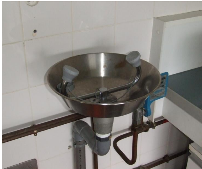
29. Appareil pour se rincer les yeux en cas de projection accidentelle. (Cl. P. Rosini)
