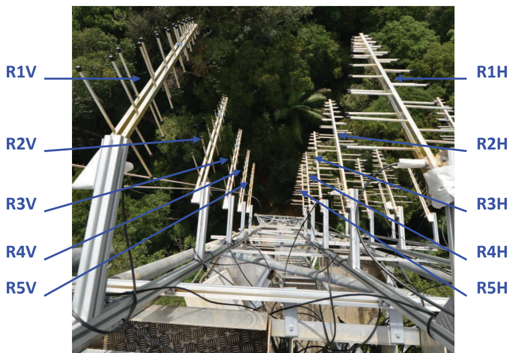
Figure 40. Montage sur la tour des antennes correspondant à la réception des polarisations V et H.
