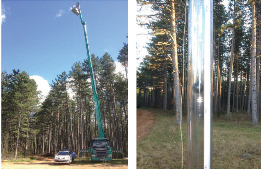
Figure 18. Camion nacelle avec les antennes fixées sur celle-ci (gauche) et système de mesure du déplacement vertical (droite).
