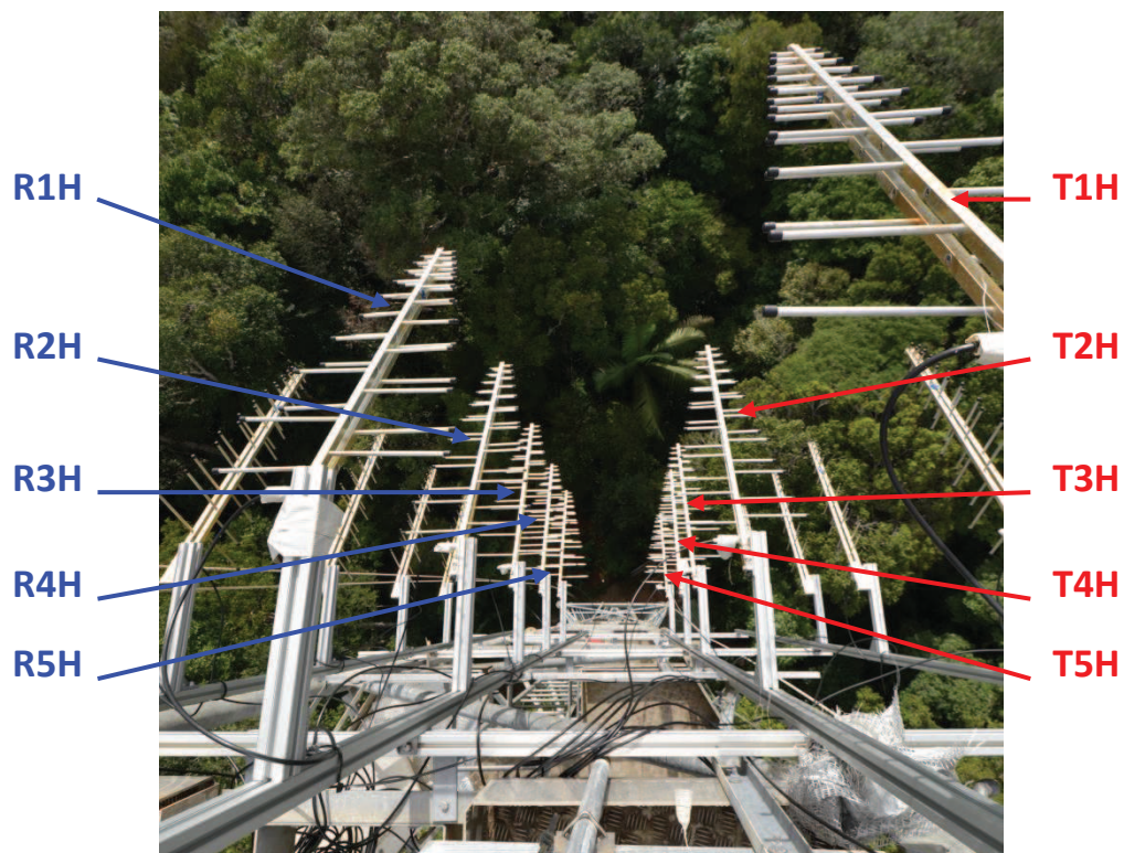
Figure 39. Montage sur la tour des antennes correspondant à la réception en H et à la transmission en V.
