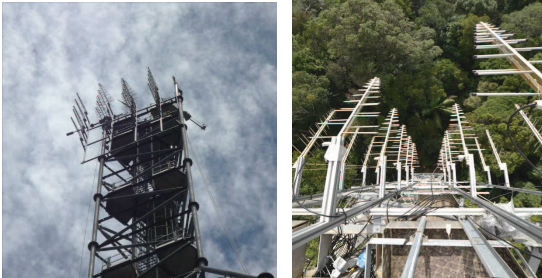
Figure 11. TropiScat : Réseau d'antenne vu de l'extérieur (gauche) et vu d'en haut de la tour (droite).
