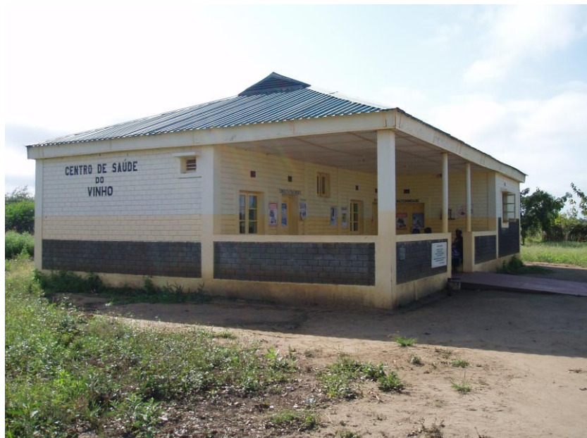
Centre de santé du village de Vinho, district de Nhamatanda, financé par le PRG, dans la zone tampon du parc national de Gorongosa.
