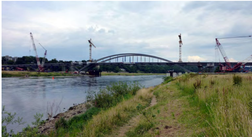
FIGURE 10-12 : Pont routier en construction dans la vallée de l’Elbe, près de Dresde (Allemagne), qui a entraîné le retrait du site de la Liste du patrimoine mondial. Photo : Mathieu Dormaels, 2011.
