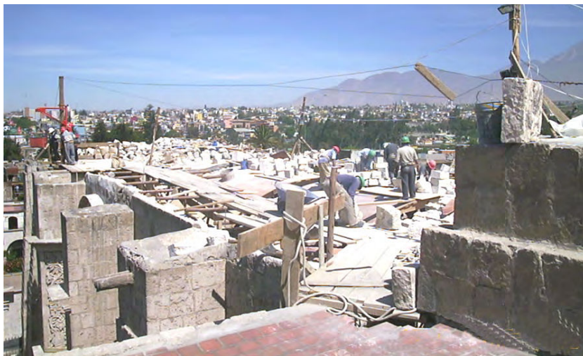
FIGURE 9-15 : Travaux de restauration de la voûte principale de l'église du Tiers-Ordre franciscain à Arequipa en 2003. Photo Municipalidad Provincial de Arequipa, 2003.
