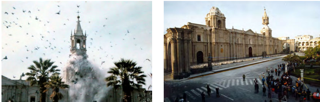
FIGURE 9-1 : Cathédrale d'Arequipa pendant (à gauche) et après (à droite) le tremblement de terre du 23 juin 2001. Photos : Fredy Salcedo, 2001.
