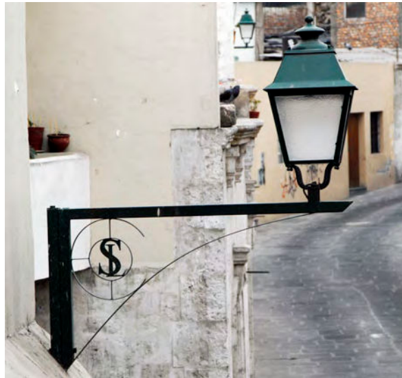
FIGURE 9-33 : Éclairage public installé lors des travaux de réhabilitation du quartier San Lázaro. Photo; Mathieu Dormaels, 2011.
