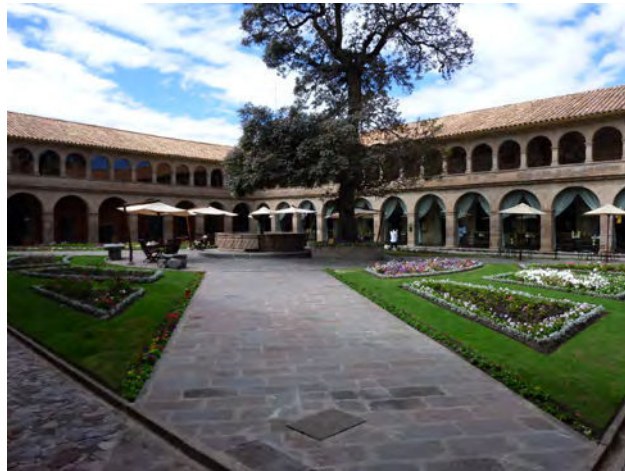
FIGURE 9-9 : Cour centrale de l'Hotel Monasterio à Cusco. Photo : Mathieu Dormaels, 2011.
