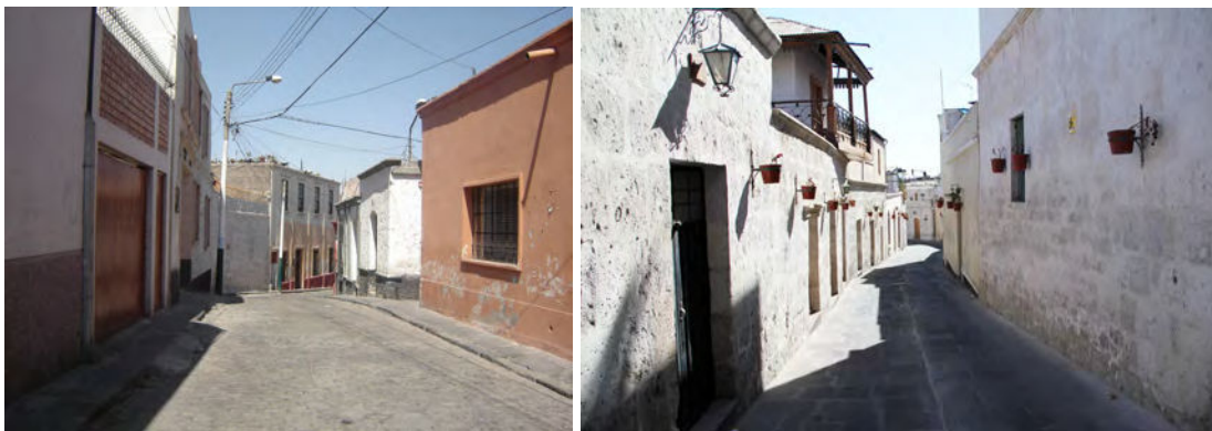
FIGURE 9-32 : Rue du quartier San Lázaro avant (à gauche) et après (à droite) les travaux de réhabilitation. Photos : Municipalidad Provincial de Arequipa, 2006 ; Luc Noppen, 2011.
