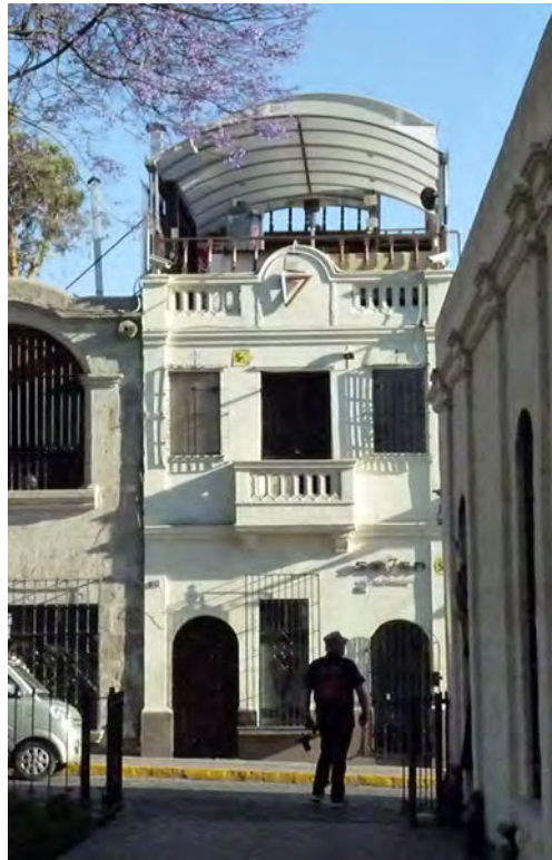
FIGURE 7-14 : Extension par l'aménagement et la couverture des toits terrasse. Photo : Mathieu Dormaels, 2011.
