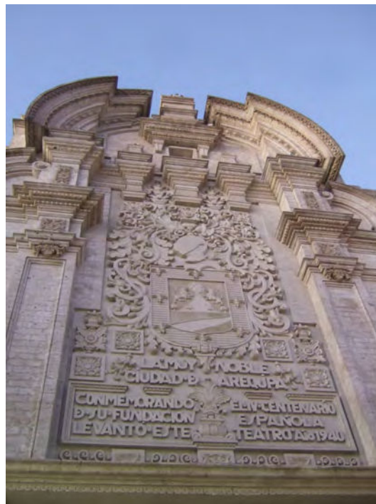
FIGURE 9-21 : Détail de la façade du théâtre municipal d'Arequipa. Photo : Mathieu Dormaels, 2011.
