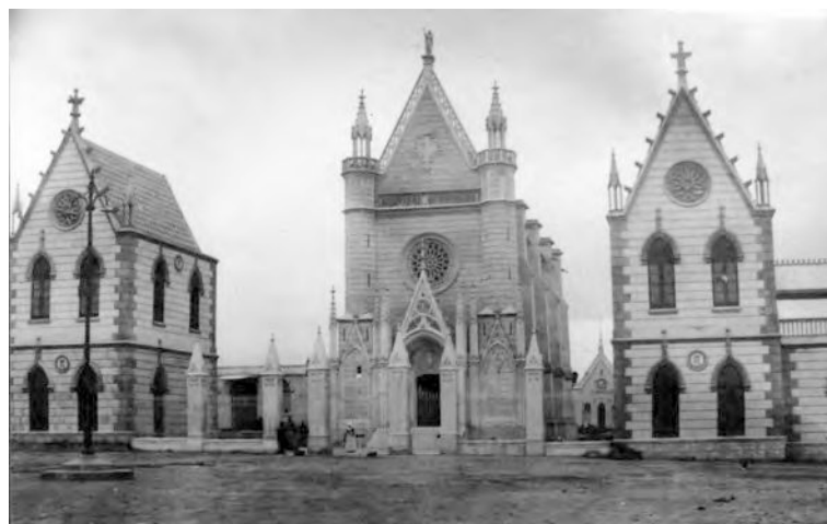
FIGURE 6-18 : Hôpital Goyeneche vers 1912. Source inconnue.
