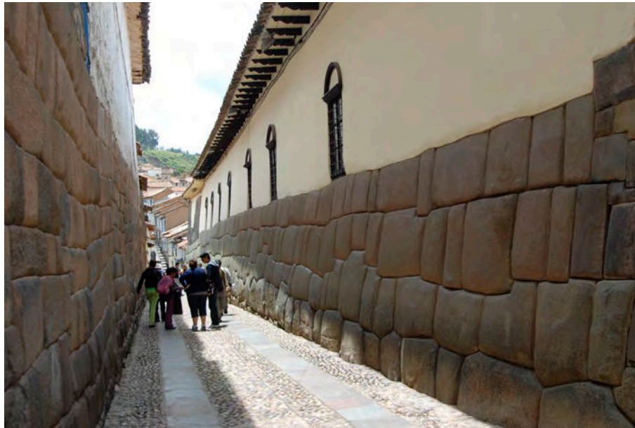
FIGURE 1-1 : Construction espagnole de l'archevêché sur les soubassements du palais de l'Inca, Cusco, Pérou. Photo : Mathieu Dormaels, 2011.
