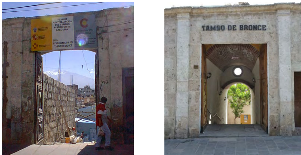
FIGURE 9-36 : Entrée principale du Tambo de Bonce pendant les travaux de restauration (à gauche) et en 2011 (à droite). Photos : Municipalidad Provincial de Arequipa, 2002 ; Mathieu Dormaels, 2011.
