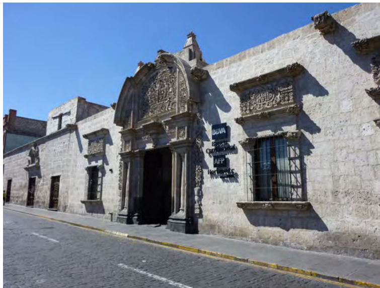
FIGURE 7-3 : Bâtiment dit Casa Tristán del Pozo, construit vers 1730, aujourd'hui siège de la succursale locale du Banco Continental. Photo : Mathieu Dormaels, 2011.
