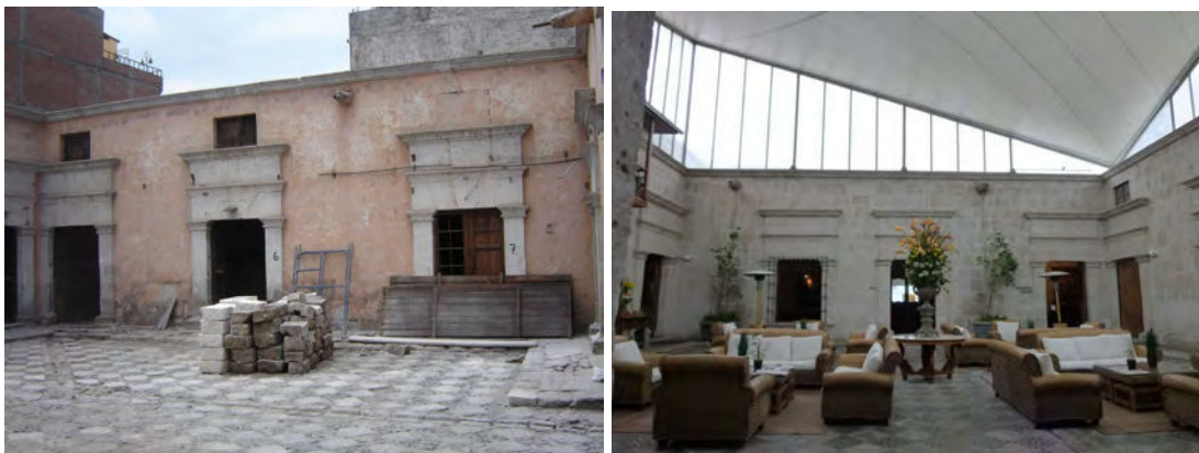
FIGURE 7-13 : 1 er patio du bâtiment dit Casa de la Moneda, avant et après sa transformation en hôtel. Photos : Municipalidad Provincial de Arequipa, 2004 ; Mathieu Dormaels, 2011.
