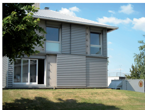
Figure 21 : Maison MARIA du Centre Scientifique et Technique du Bâtiment (CSTB)
