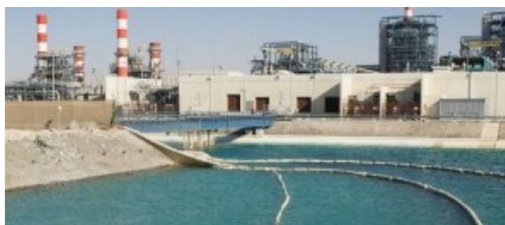
Prises d'eau de l'usine de dessalement d'eau de mer d'Ashkelon
