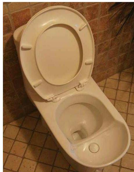
**Figure 1-9 : Exemple de toilettes permettant une séparation liquide/solide. Photographie d'un urinoir Urinus (Berger Biotechnik GmbH) (photographie de droite) et d'une toilette séparatrice Dubbletten ([www.dubbletten.nu](http://www.dubbletten.nu)).**
