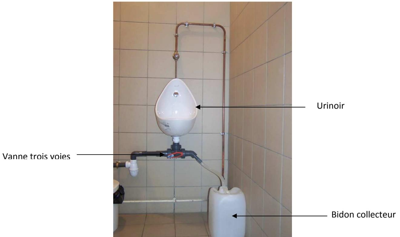
**Figure 2-8: Dispositif de collecte d'urine.**
