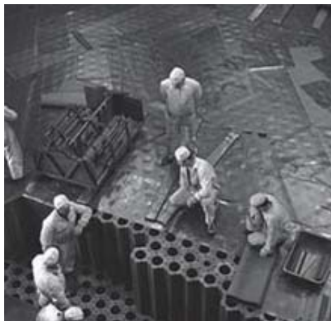
Figure 3 : Construction des empilements de graphites
