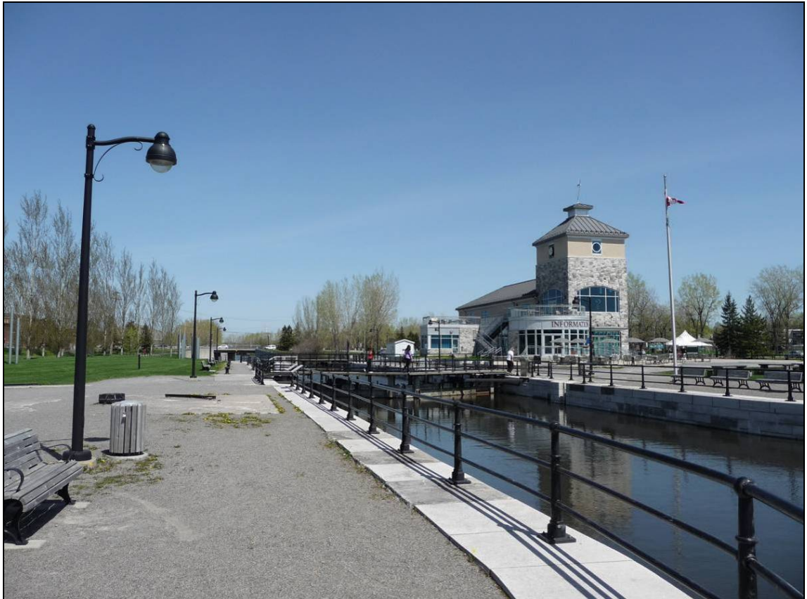
Figure 29 : Vue vers l'est de l'écluse de Lachine (no. 5), du chalet d'accueil du lieu historique national du Canada du Canal-de-Lachine et du pont Huit.
