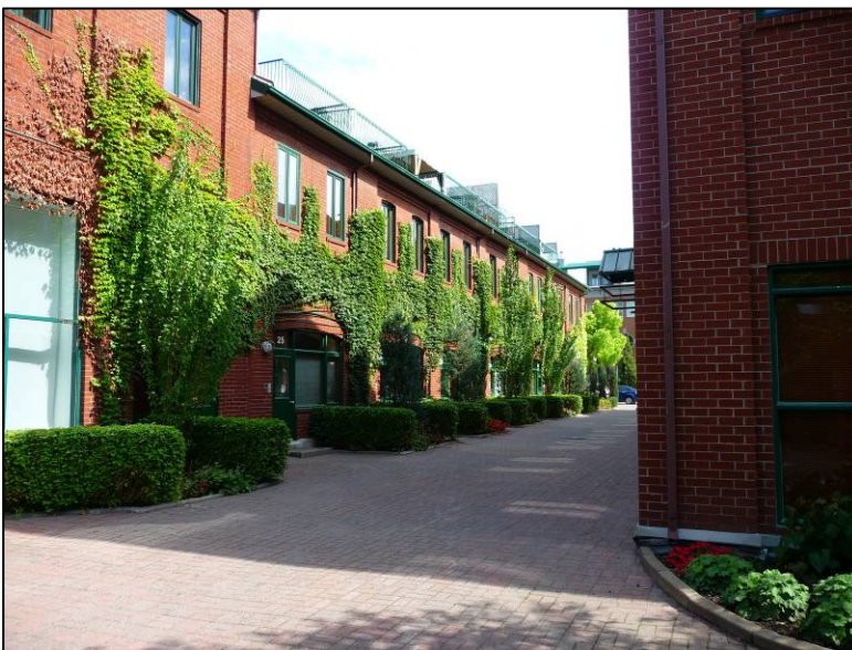
Coursive à l'intérieur du cours Dominion.
