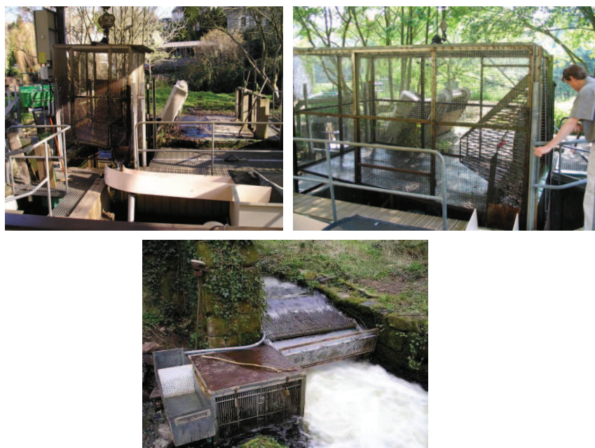
Figure 5: Les dispositifs de piégeages sur le Scorff : Le Moulin des Princes (photos du haut) et le Moulin du Leslé (photo du bas).
