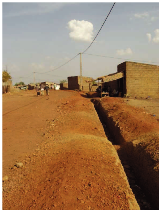
Photo 10 : Prolongement du réseau privé d'adduction en eau par l'EDM à partir des bornes fontaines réalisées par le PDSU dans le quartier de Sikoroni, février 2008, (BOURSE).
