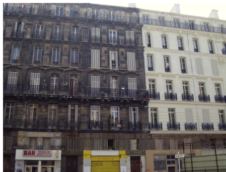
Photo 26 : Réhabilitation des logements haussmanniens de la rue de la République, octobre 2007, (BOURSE).
