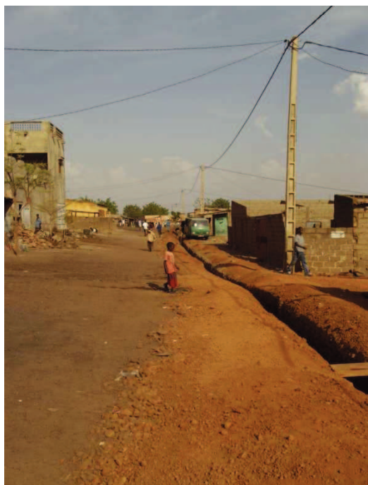
Photo 9 : Prolongement du réseau privé d'adduction en eau par l'EDM à partir des bornes fontaines réalisées par le PDSU dans le quartier de Sikoroni, février 2008, (BOURSE).
