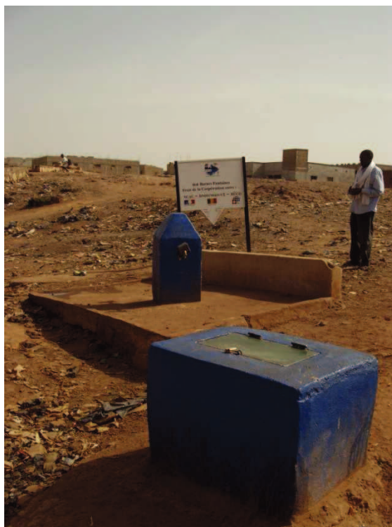
Photo 12 : Borne fontaine n°2 réalisée par le PDSU dans le quartier de Banconi, février 2008, (BOURSE).
