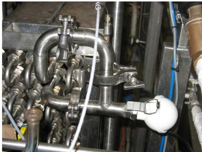
Figure 52 : Implantation du capteur FS sur l'échangeur de chaleur tubulaire (site industriel)
