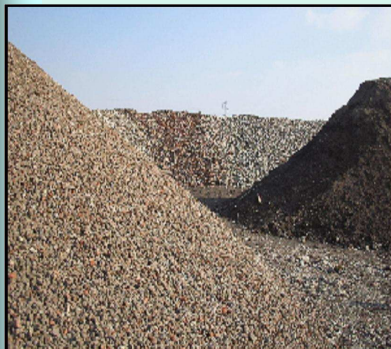
Quadrillage, décaissement, criblage et tri des terres pollués
