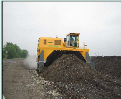
Mise en place et retournement des andins pour accélérer la dégradation biologique de certains polluants
