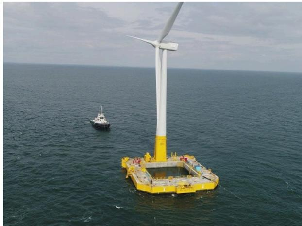
FIGURE 1.1. – Démonstrateur Floatgen de BW Ideol au large du Croisic en opération depuis 2018
