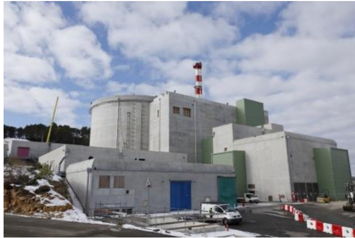
Figure 9 Bâtiment réacteur du RJH sur le centre CEA de Cadarache
