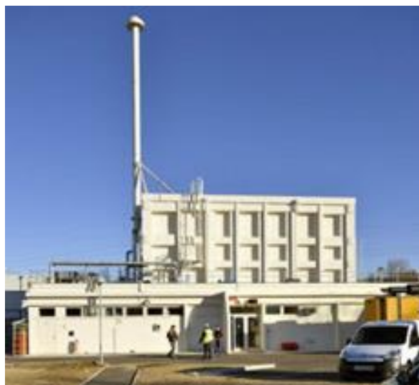
Figure 6 Bâtiment du réacteur CABRI [6]
