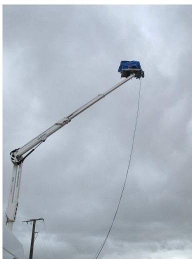
Figure 2. Nacelle après installation
