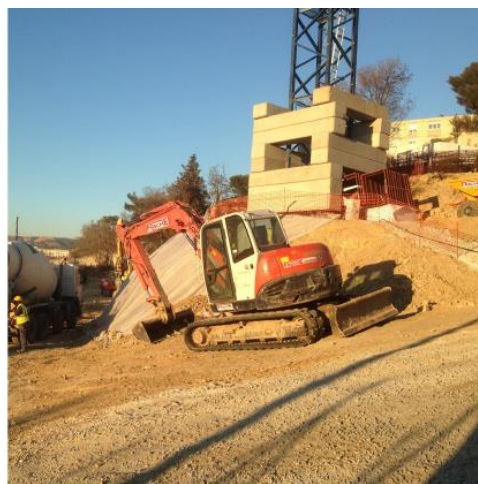
Travaux en cours, bastide démolie Photo prise par M. Serre (2016)
