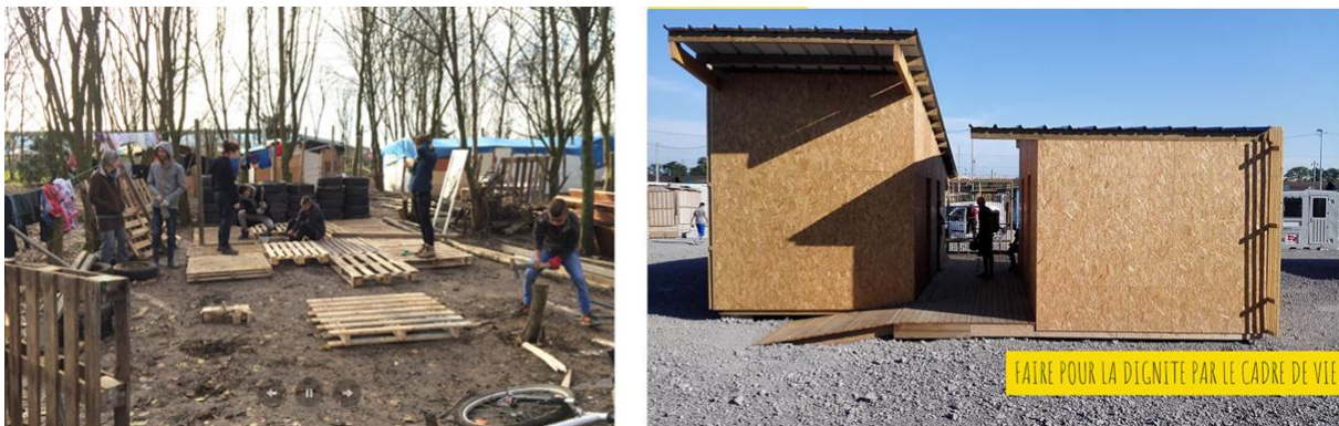
Figure 180 : Une école co-construite par SystèmeB et les habitants d'un bidonville de Seine-et-Marne, 2016 (source : https://systemebidonville.com ) et un centre juridique administratif, 2016 (source : https://www.actesetcites.org )
