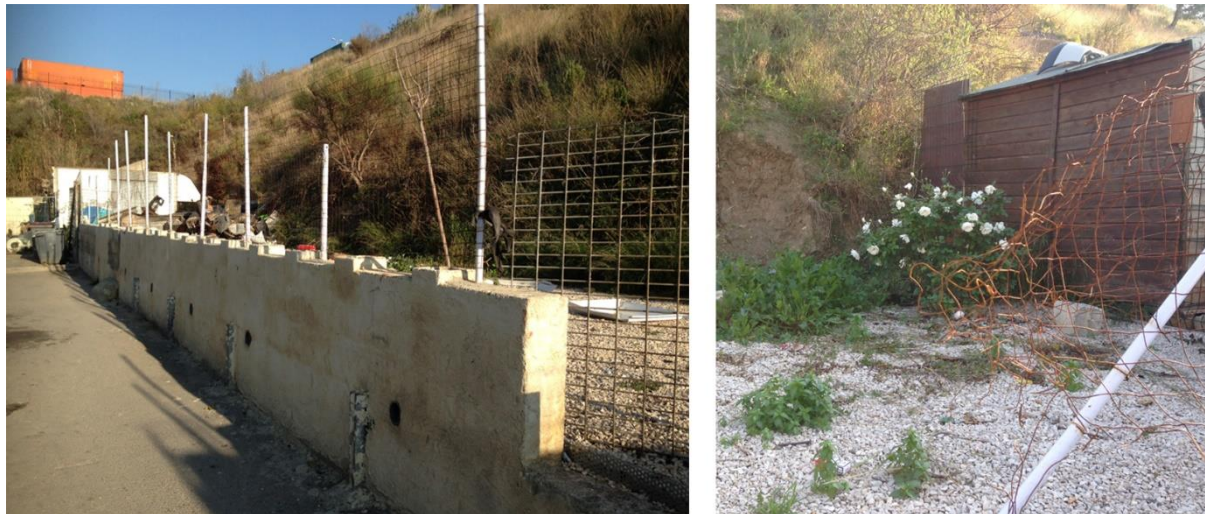
Figure 230 : Vue du grillage installés par les habitants et des rosiers, décembre 2016, photo prise par M. Serre
