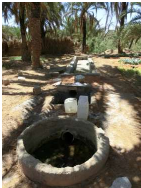
Confection de bassin et seguia en ciment
