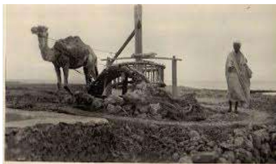
Photo n° 14 : Système d'irrigation traditionnel la « Nouria ».
