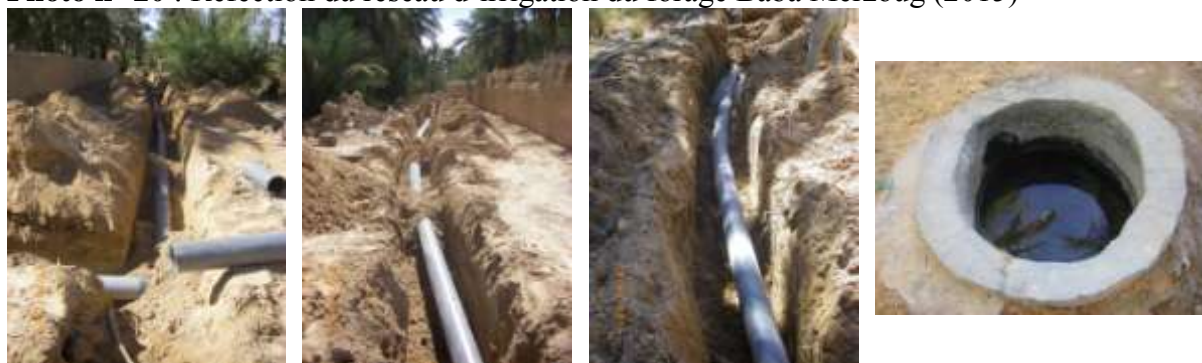
Photo n° 20 : Réfection du réseau d'irrigation du forage Baba Merzoug (2015)
