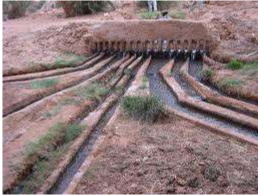
Photo n° 12 : Répartiteur d'une Foggara
