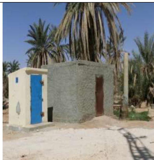
Forage électrifié avec abris de forage
