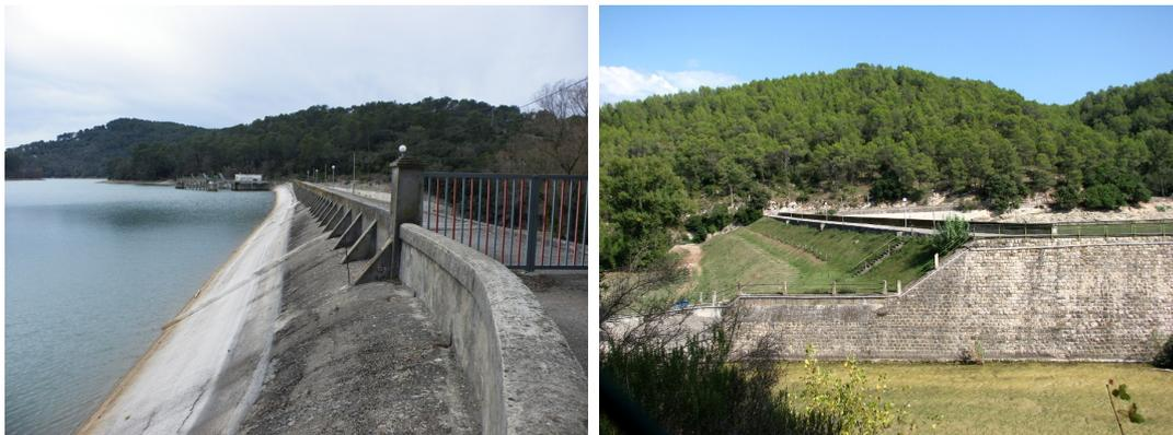
FIGURE 2.2 – Vue amont et aval du barrage du lac de Carcès situé dans le Var. Renforcement de la pente amont par une chape de béton.
