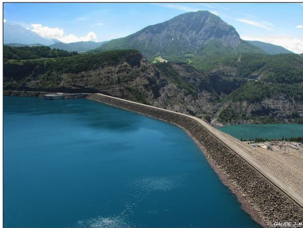
FIGURE 2.1 – Vue amont du barrage de Serre Ponçon situé sur la Durance. Renforcement du parement de l'ouvrage par un enrochement des pentes.
