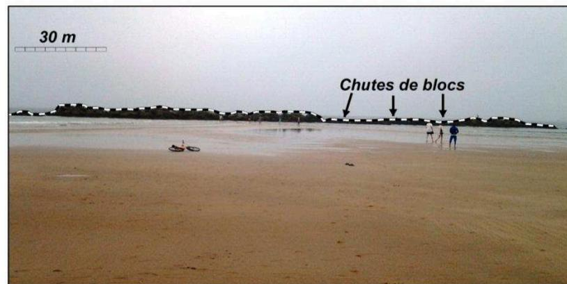
Fig V- 36 : Détérioration du brise-lames par chute de blocs entraînant une déformation de sa *côte d'arase* (2014)
