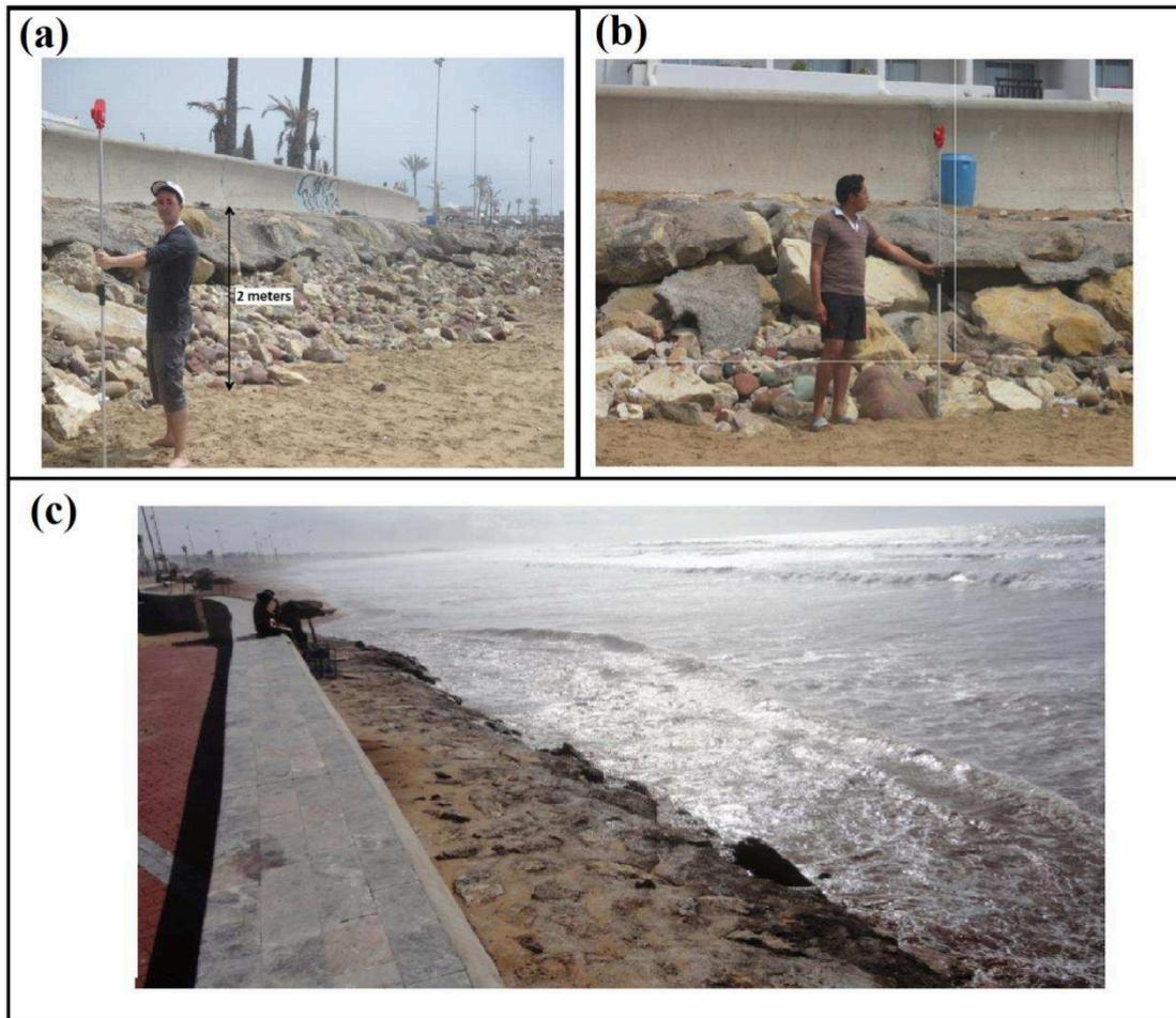
Fig V- 35 : Photos montrant les dégâts causés par les événements tempétueux au niveau des profils 6 (a) et 7 (b) et réflexion des vagues par la digue promenade durant la tempête 8
