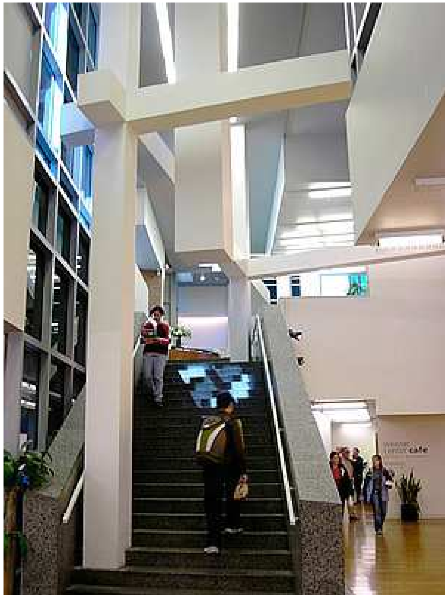
Figure 87. Peter Eisenman, Wexner Center for the Visual art and fine arts Library , Columbus, Ohio, 1983-1989. Les poteaux et poutres inachevés sont les quelques cas de déformation plastique, peu nombreux, présents dans le projet.
