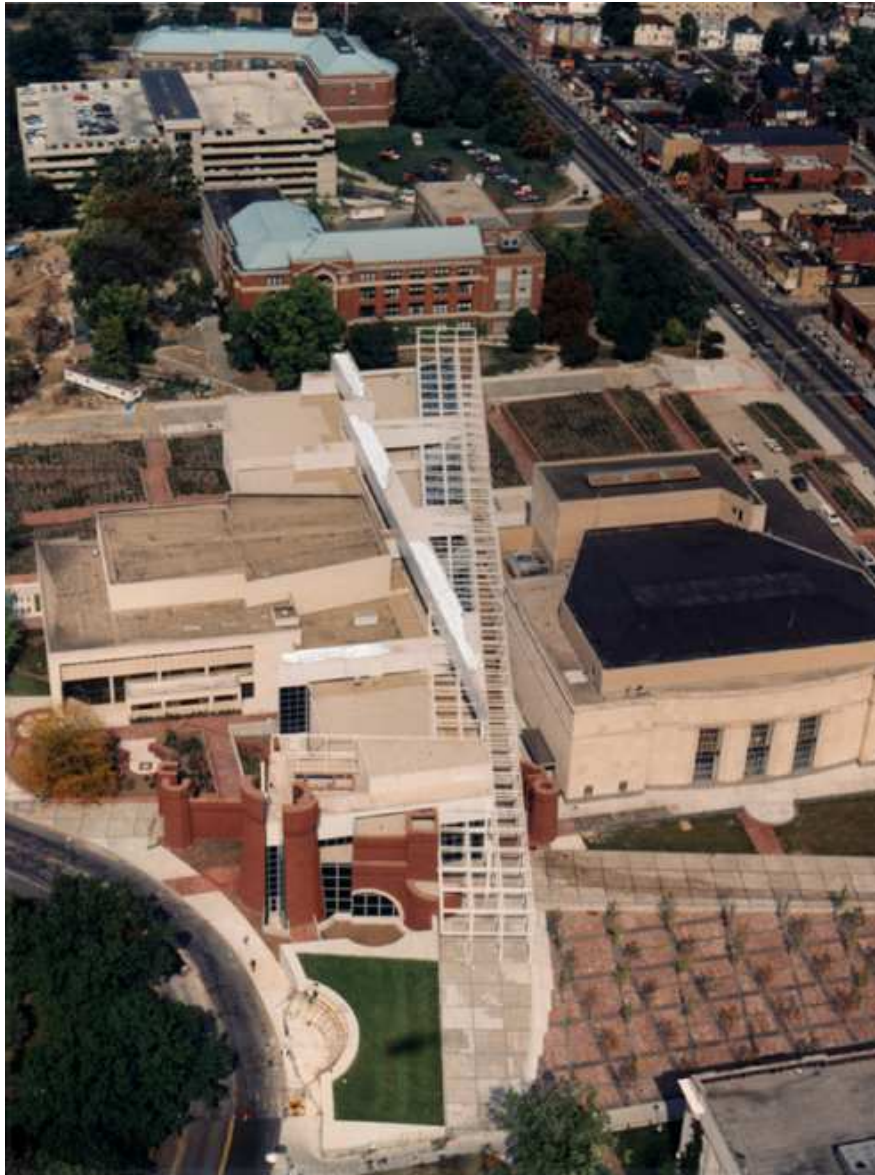
Figure 86. Peter Eisenman, Wexner Center for the Visual art and fine arts Library , Columbus, Ohio, 1983-1989. La grille métallique et sa position en diagonale (12,25 degrés).
