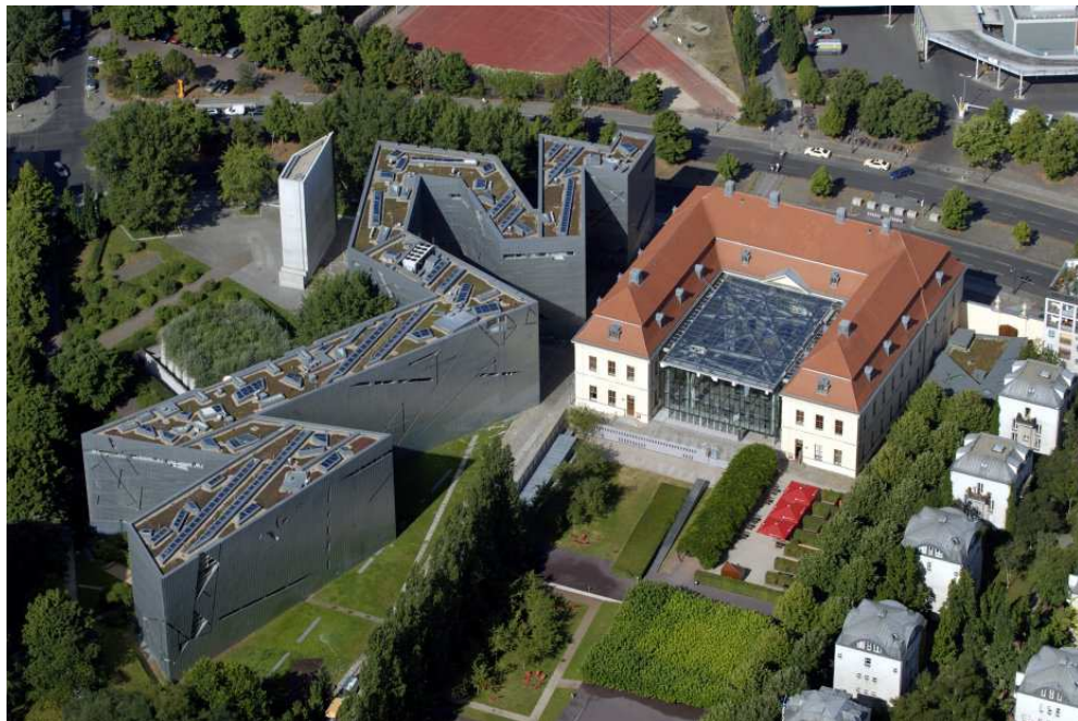
Figure 26. En haut : le traitement fragmenté des fenêtres avec les ouvertures linéaires qui se croisent et qui créent des fragments en forme de cicatrice sur la façade. En bas : la forme en zigzag du musée, et à droite, le bâtiment baroque, où se trouve l'entrée du musée.
