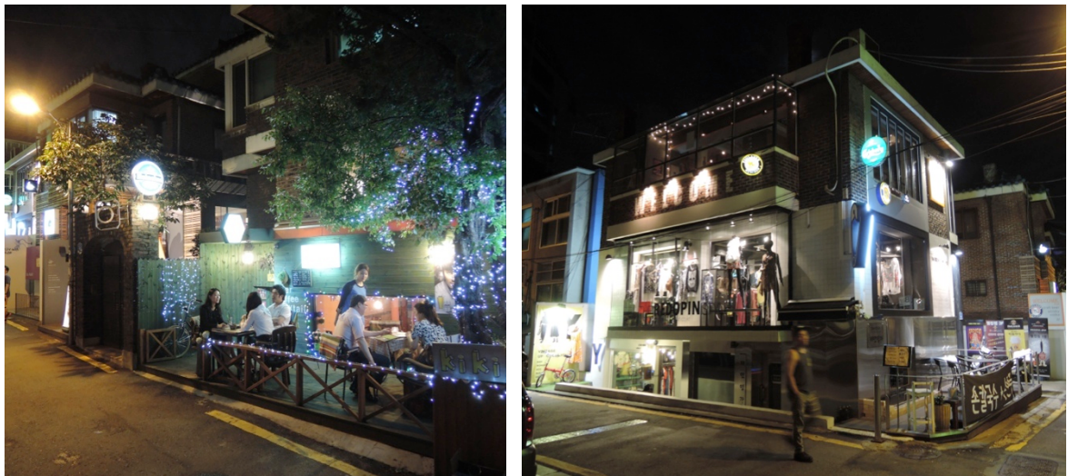
Figure 56. Transformation des logements collectifs en l'activité commerciale
