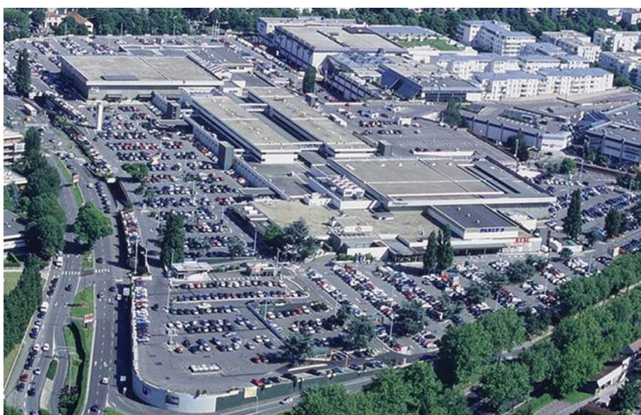
Figure 36. Vue aérienne sur le centre commercial régional Parly 2
