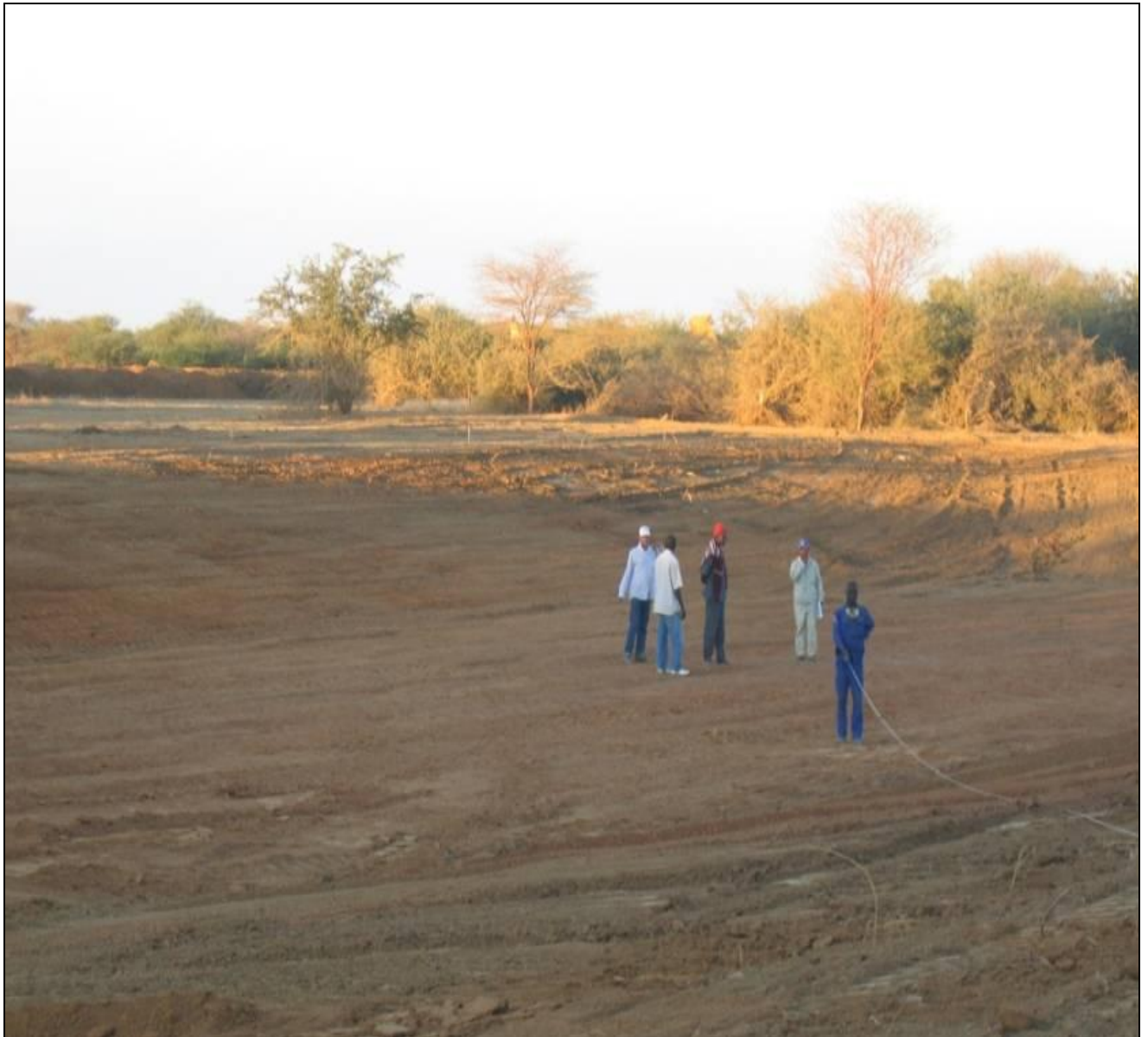
Surcreusement d'une mare artificielle par le PHPTC dans la région de Mongo. Durant la descente au Sud, les transhumants venant du Nord s'arrêteront quelques semaines pour abreuver leurs animaux dans cette mare (Cliché Ali Adoum Manané, Mongo, novembre 2006).
