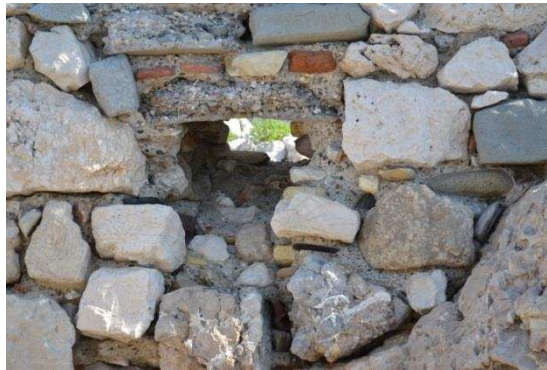
Figure 334 : Chantepleure dans le mur contemporain (cl. Stéphane Morabito/SAVN).
