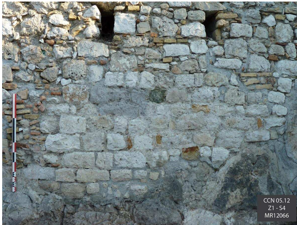
Figure 181 : MR12066 vu du sud (cl. Eric Guilloteau/SAVN).
