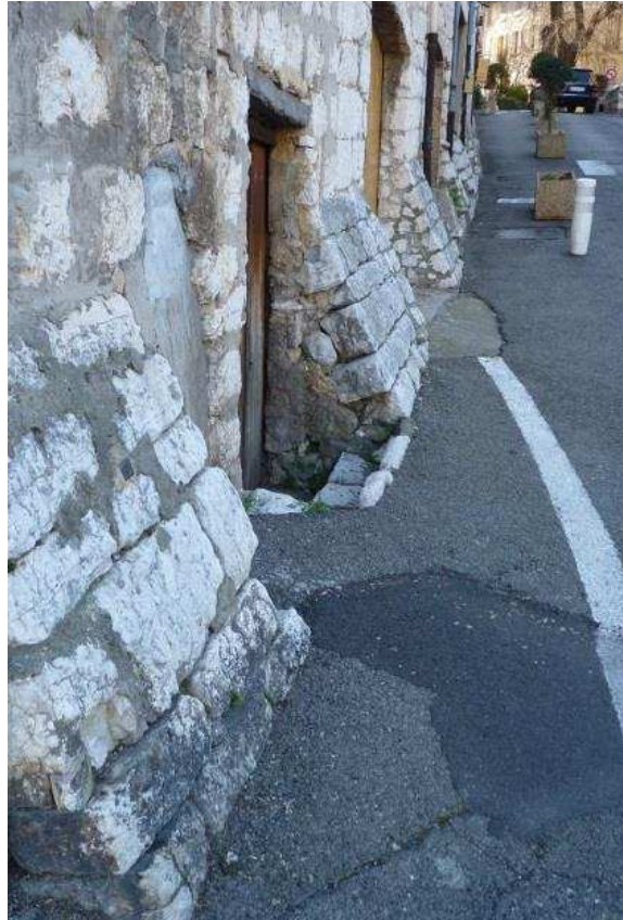
Figure 38 : Talus maçonné à la base de la muraille de Vence, s'élevant ensuite à la verticale, XV e siècle (cl. E. Guilloteau).
