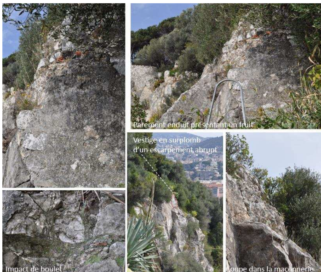
Figure 88 : Vestige de l'enceinte conservé au sud de la porte de secours, sur le front oriental (cl. E. Guilloteau).
