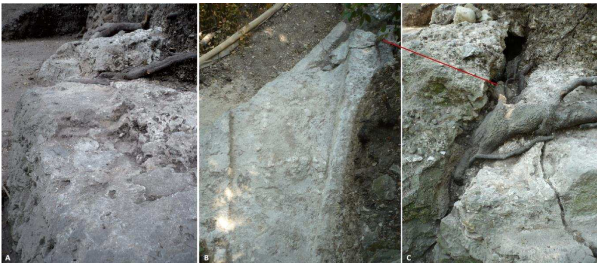
Figure 312 : (A) Démolition de la partie orientale de la tour Saint-Victor jusqu'au rocher. (B) Négatif de l'embrasure d'une canonnière. (C) Fracture dans le rocher provoquée par l'explosion, au niveau de l'embrasure de canonnière (cl. E. Guilloteau).
