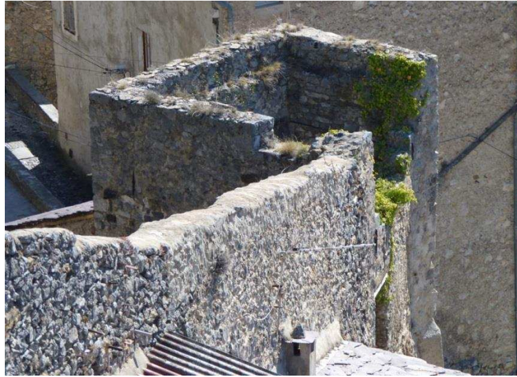
Figure 36 : Petite tour carrée de Saorge ouverte à la gorge. La gorge a été murée pour utiliser le bâtiment comme débarras. Un étage marqué par un ressaut est perceptible au niveau de l'arasement de la tour (cl. E. Guilloteau).
