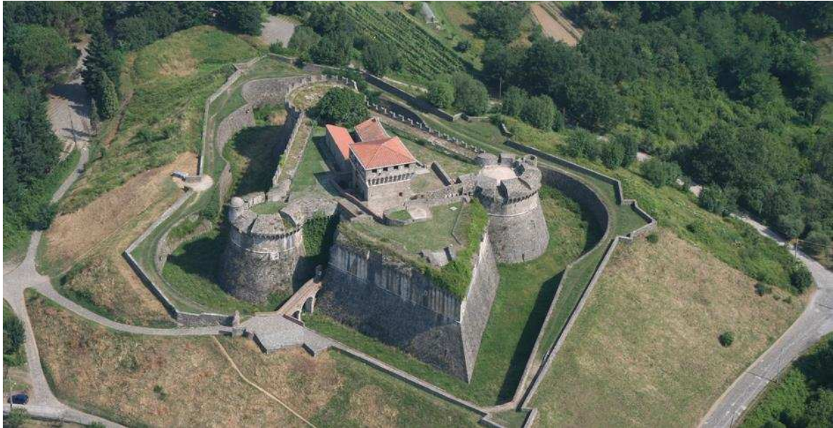
Figure 106 : Vue aérienne de la forteresse de Sarzanello avec ses trois grosses tours et sa demi-lune (cl. CC-Difesa).
