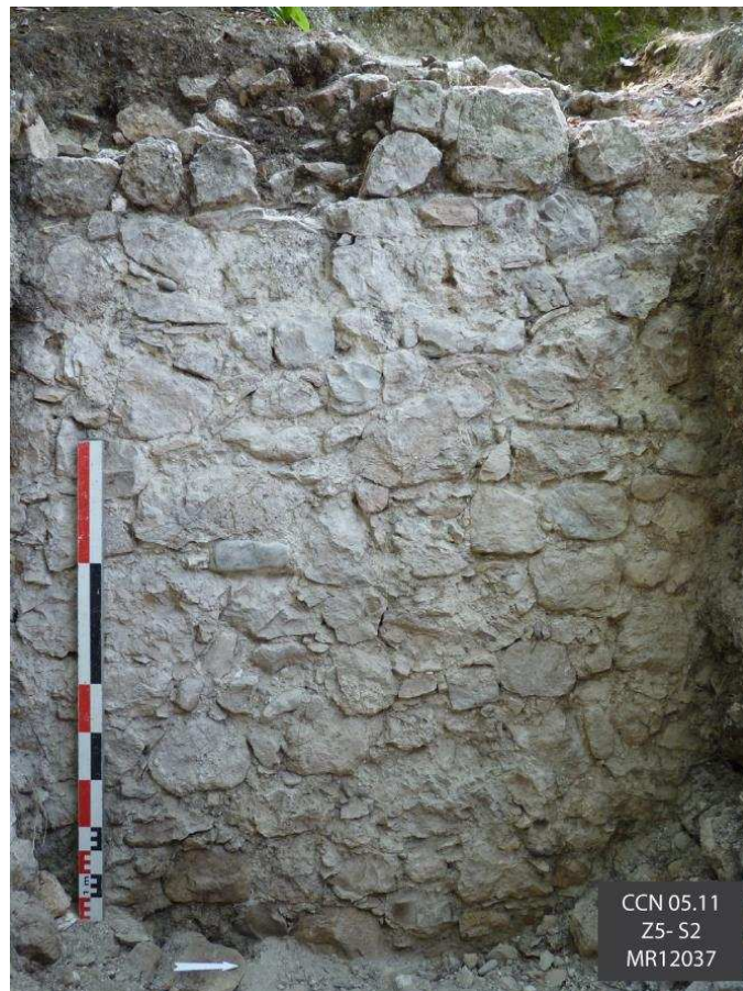
Figure 150 : MR12037, parement est (Cl. E. Guilloteau/SAVN).
