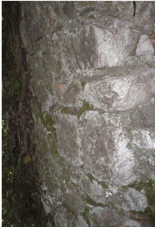
Figure 54 : Détail du vestige 22003, avec un parement de pierres de taille (redressé) (Cl. E. Guilloteau/SAVN).
