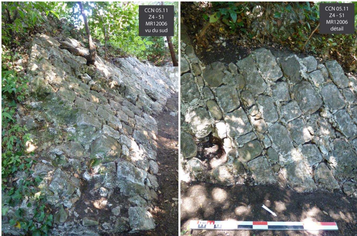
Figure 172 : MR12006 avec un appareil bien réglé, sans calage de briques (Cl. E. Guilloteau/SAVN).
