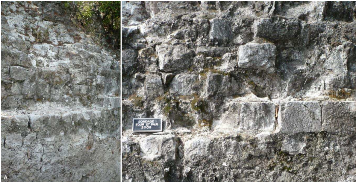
Figure 311 : Base du boulevard Saint-Paul - (A) Détail montrant une partie intacte et le blocage sous la salle basse encore en élévation - (B) Détail d'un reste d'assise de pierres de taille, présentant les négatifs de certaines (cl. E. Guilloteau).
