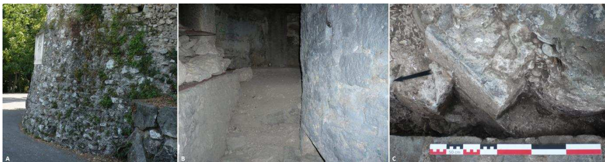
Figure 313 : (A) Blocage encore en élévation sous la salle basse, dans la partie occidentale de la tour. (B) Partie inférieure de la cage d'escalier épargnée, desservant la casemate basse. (C) Partie haute de la cage d'escalier solidement accrochée au rocher (cl. E. Guilloteau).
