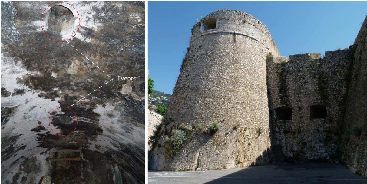
Figure 177 : Casemate et ses deux événements du bastion nord-ouest, le bastion nord-est lui faisant face, avec son flanc percé de deux embrasures (cl. E. Guilloteau).
