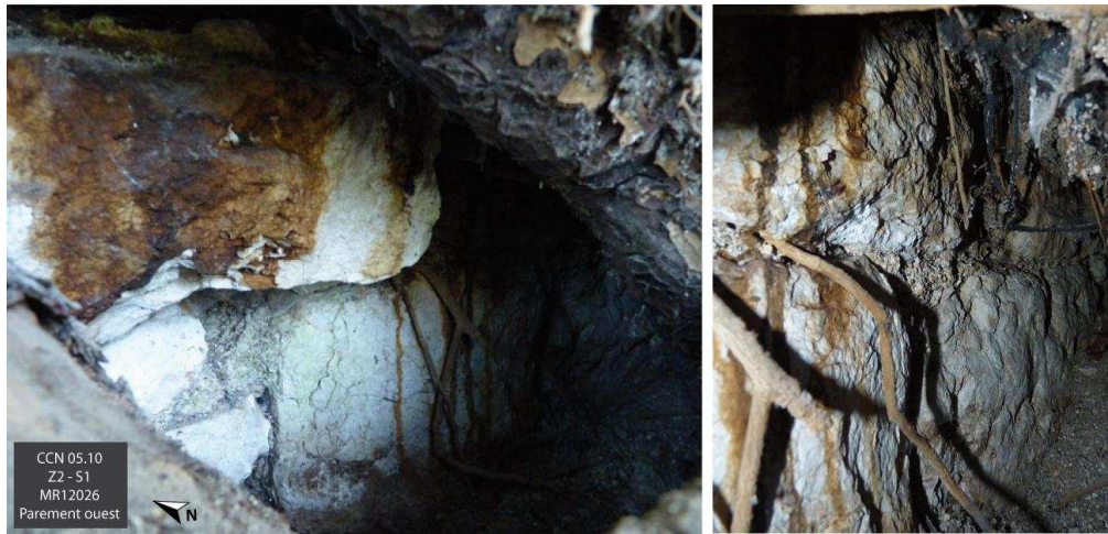
Figure 103 : Parement ouest de MR12026, conservé sous les racines d'un pin (Cl. E. Guilloteau/SAVN).
