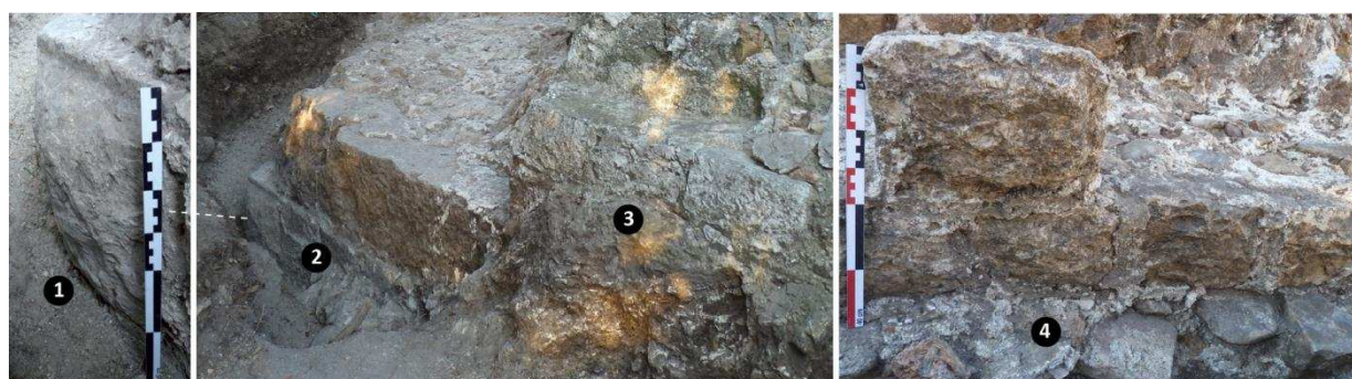
Figure 29 : Comparaison entre : (2) la fondation de [T. 7] (SB 12218, SB 12021) comprenant un grand appareil et un bossage de qualité (détail en (1)) (3) une phase postérieure de l'élévation (MR 12014) en moyen appareil (4) la courtine sud (MR 12023, 12065, 12074) en moyen appareil et pierres à bossage ponctuelles (cl. E. Guilloteau).
