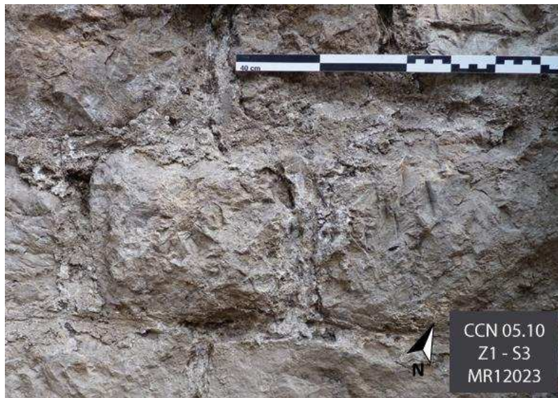
Figure 83 : Détail des blocs avec taille en bossage (Cl. E. Guilloteau/SAVN).
