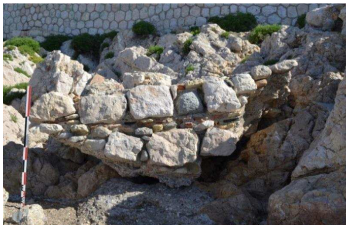
Figure 335 : L'une des sections basculée du mur contemporain (cl. Stéphane Morabito/SAVN).
