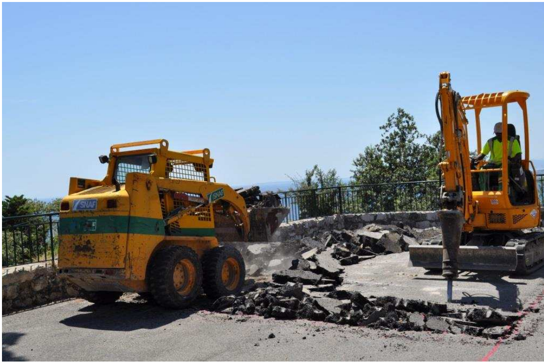
Figure 220 : Découpe du bitume sur la zone 6 – secteur 1 (cl. Eric Guilloteau/SAVN).
