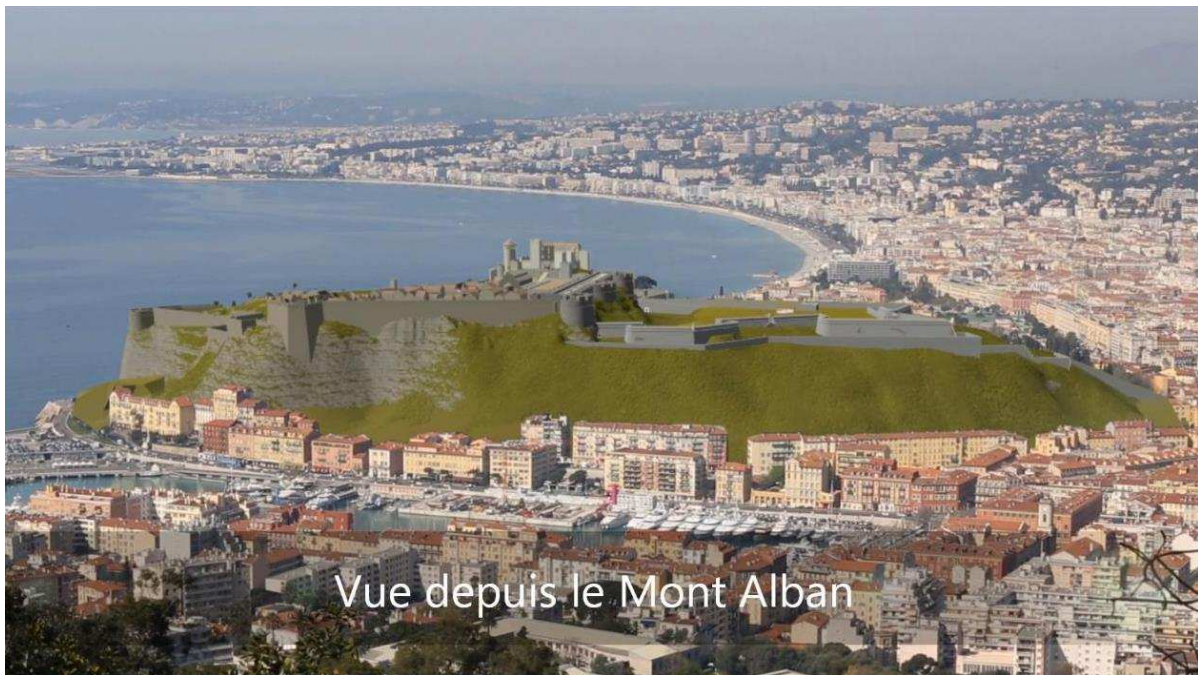
Figure 346 : Réalité augmentée depuis Montalban (Réalisation des Bâtiments Communaux).
