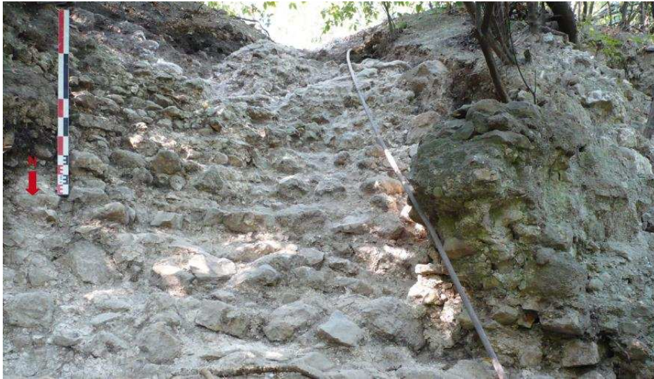
Figure 36 : Mise au jour d'une partie du blocage de la courtine entre 21020 et 21021 (Cl. E. Guilloteau/SAVN).
