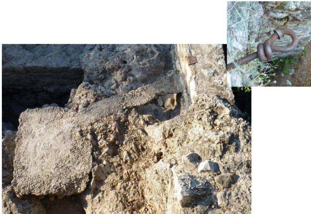
Figure 213 : Bloc de béton avec l'anneau de poulie à son extrémité (cl. E. Guilloteau/SAVN).
