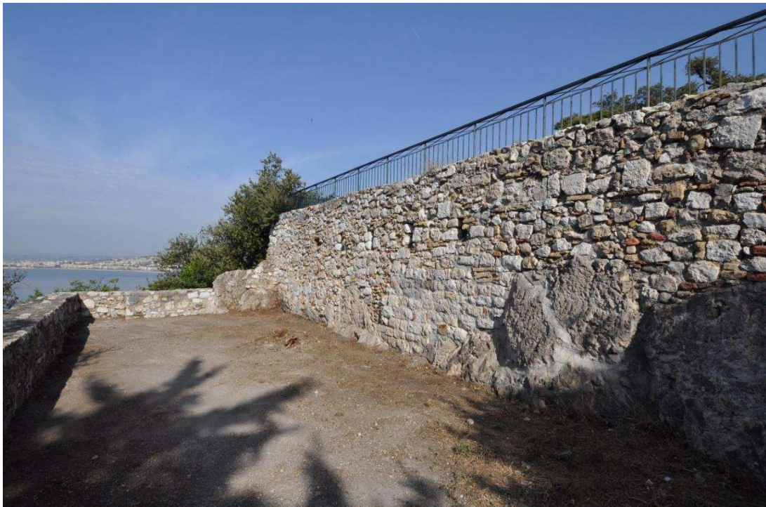
Figure 210 : Vue générale des reprises modernes en élévations sur le secteur 4 (cl. Eric Guilloteau/SAVN).
