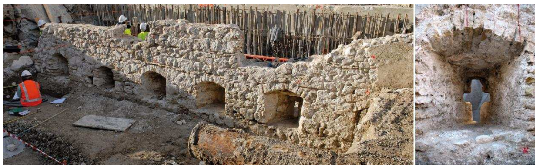
Figure 84 : Aile nord-ouest du ravelin de la porte Pairolière en cours de dégagement et détail d'une arbalétrière (Cl. L. Colonna/INRAP).
