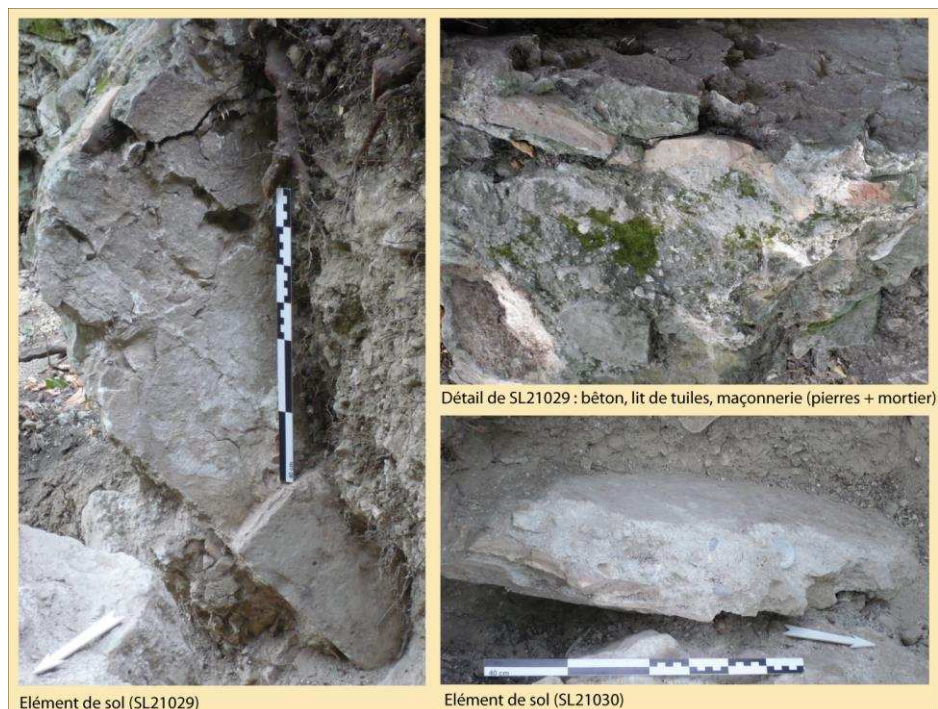
Figure 50 : SL21029 et SL21030, pouvant appartenir à la plate-forme sommitale de la tour Saint-Charles (Cl. E. Guilloteau/SAVN).
