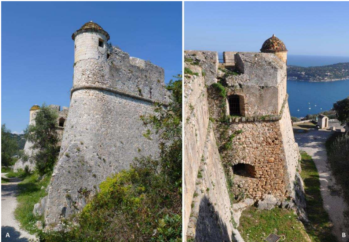
Figure 182 : (A) Angle flanqué à éperon du bastion nord. (B) Ouvertures de tir dans le flanc du bastion sud (cl. E. Guilloteau).
