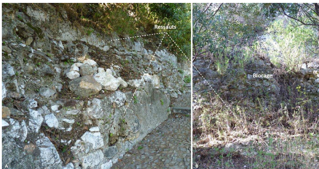
Figure 87 : (A) Système de ressauts à la base de la courtine ; (B) Ressaut et blocage de la courtine s'élevant vers le plateau supérieur (cl. E. Guilloteau).
