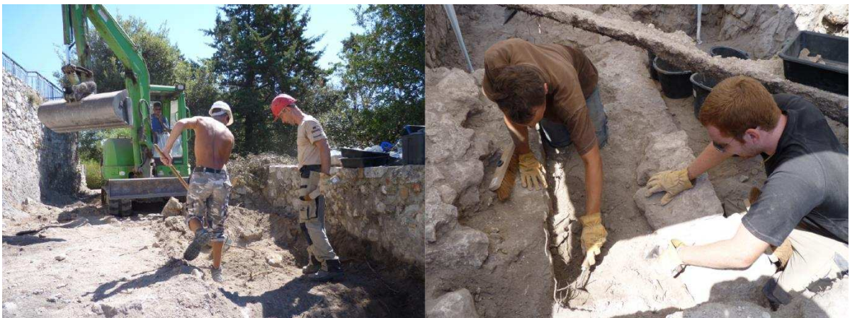
Figure 176 : Conditions techniques de l'opération (cl. E. Guilloteau/SAVN).
