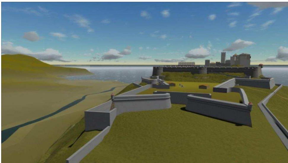
Figure 339 : Citadelle vue du nord, avec la tête de l'ouvrage à cornes, ses deux demi-bastions et leurs échauguettes.
