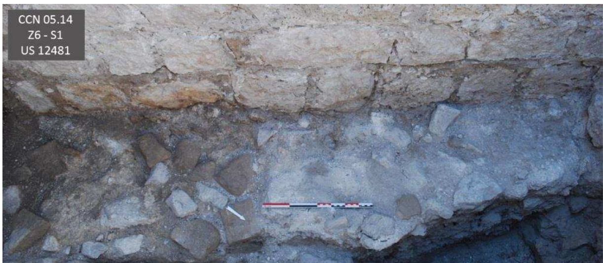
Figure 290 : Semelle de fondation de MR 12080 (US 12780) (cl. E. Guilloteau/SAVN).
