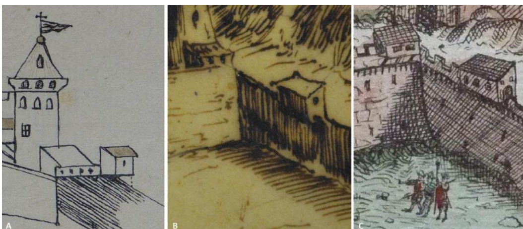
Figure 137 : Petits bâtiments, en saillie ou pas, aux niveaux de l'éperon et de la muraille du XV e siècle : (A) Borriglione – vers 1595. (B) Balduino – 1610. (C) Anonyme - 1579 (cl. E. Guilloteau).
