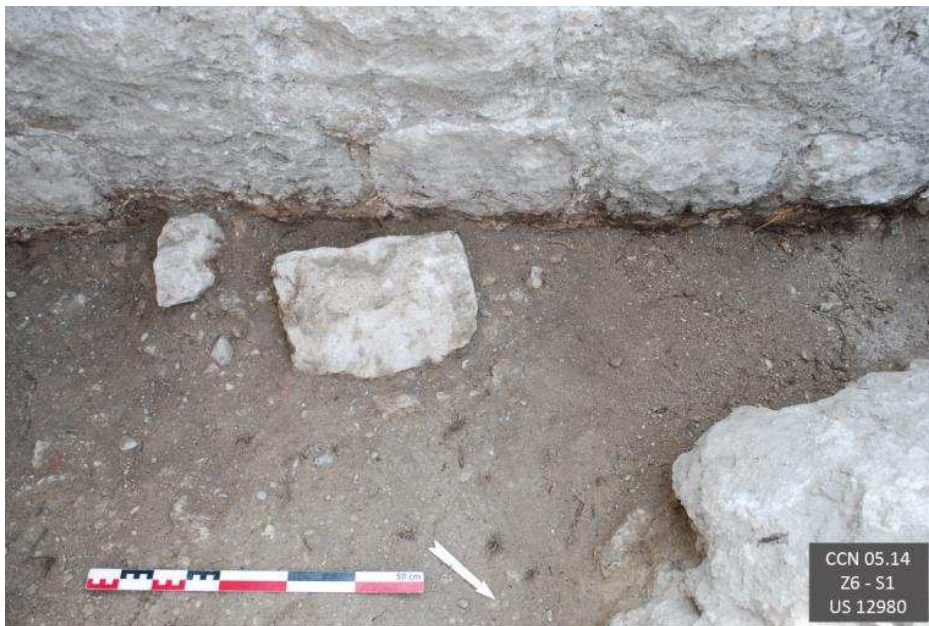
Figure 293 : Vue cavalière de l'US 12980 à partir du nord-est (cl. E. Guilloteau/SAVN).
