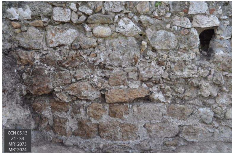
Figure 225 : MR 12074, composé d'une semelle de fondation et de deux assises (cl. E. Guilloteau/SAVN).
