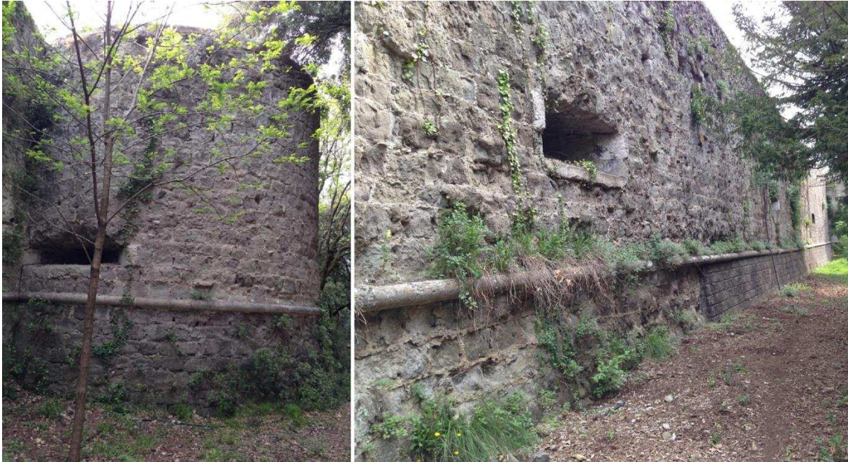
Figure 110 : tour et courtine de l'enceinte du XVI e siècle du château de Villeneuve-Loubet (cl. N. Faucherre).
