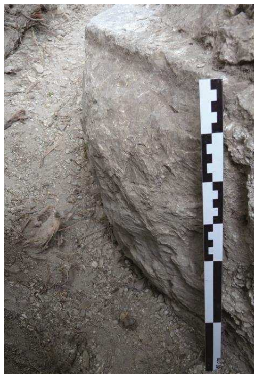
Figure 69 : Détail de la taille en bossage (Cl. E. Guilloteau/SAVN).
