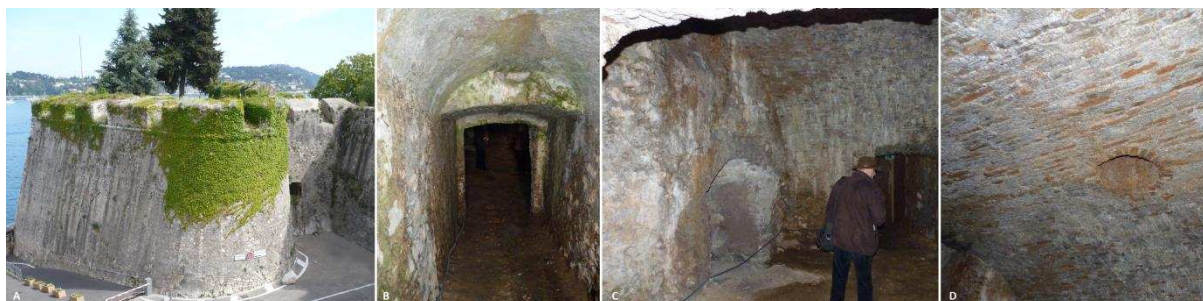
Figure 176 : (A) Bastion à orillon sud-est et son flanc percé d'une canonnère. (B) Galerie menant à la casemate du bastion. (C) Casemate. (D) Event dans la casemate (cl. E. Guilloteau).
