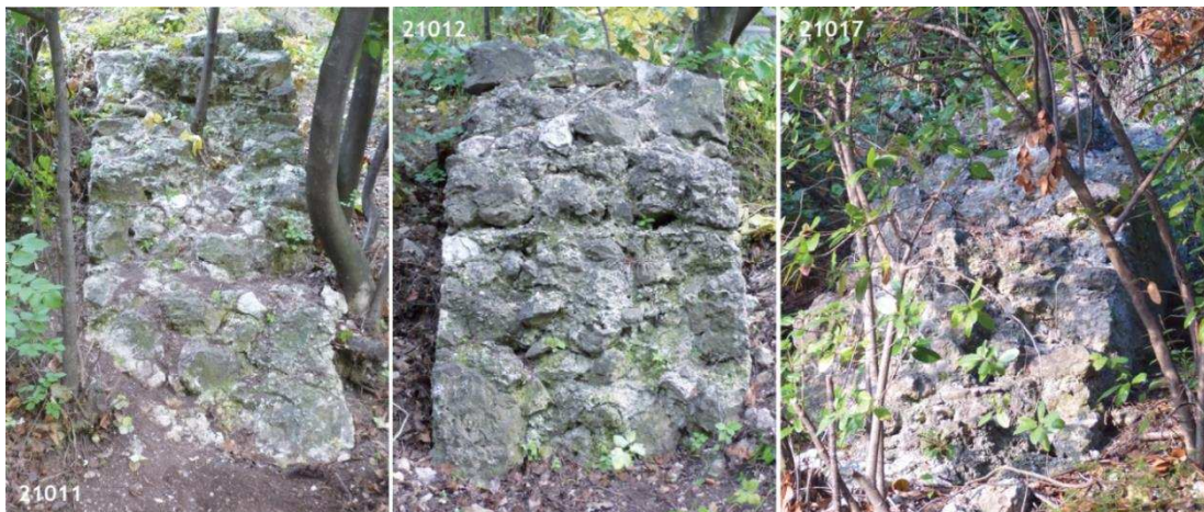
Figure 281 : Vestiges des contreforts du grand bastion oriental (23) (cl. E. Guilloteau).
