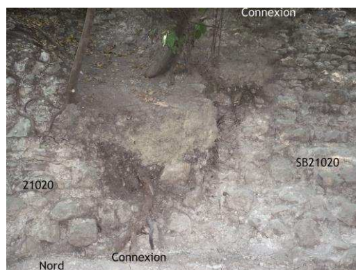
Figure 37 : Connexion entre les parties 21020 et SB21020 de la courtine (Cl. E. Guilloteau/SAVN).
