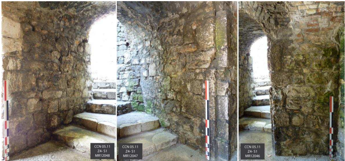
Figure 170 : Murs présentant des chaînes d'angle (Cl. E. Guilloteau/SAVN).
