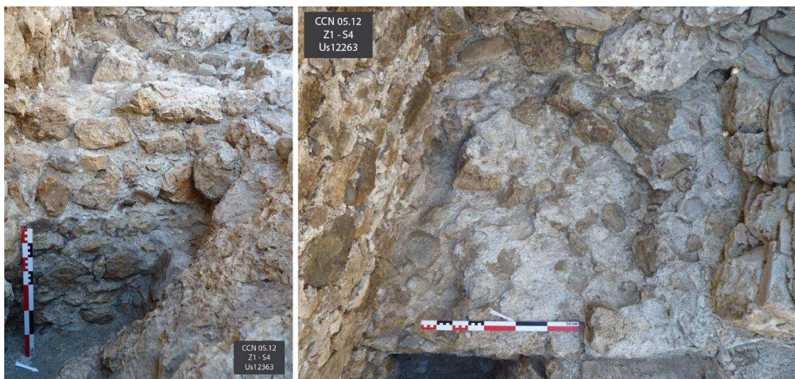
Figure 202 : Blocage banché de la structure bâtie SB 12063 (cl. E. Guilloteau/SAVN).
