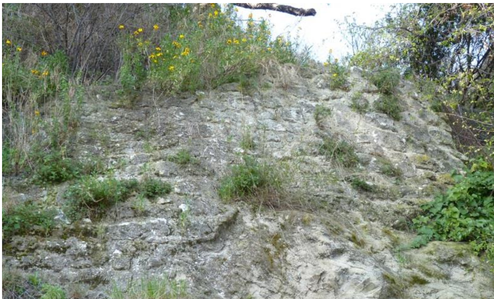
Figure 58 : Vestige de l'enceinte sur le front est, à mi-pente sur la colline, située entre la citadelle et la ville basse (cl. E. Guilloteau).
