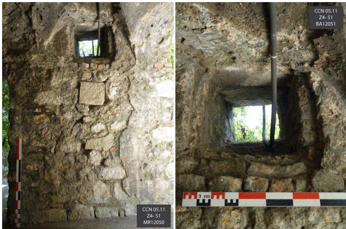
Figure 171 : MR12050 avec son puits de lumière (Cl. E. Guilloteau/SAVN).
