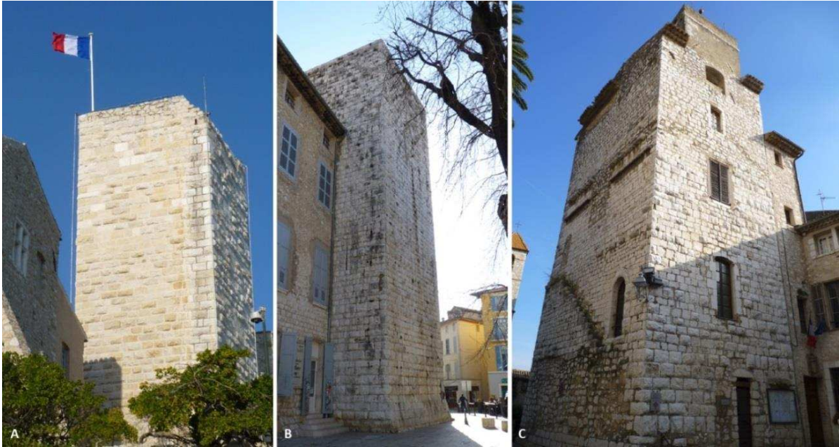
Figure 32 : (A) Tour maîtresse du château d'Antibes présentant les mêmes caractéristiques que celle de Nice. (B) Tour de Vence avec sa base talutée et un appareil à bossage. (C) Donjon de Saint-Paul de Vence avec l'ancien accès au premier étage (cl. E. Guilloteau).
