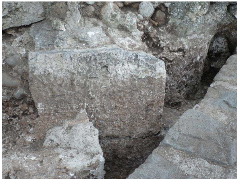
Figure 27 : Deux pierres de taille, liées par un joint fin (au-dessous, la seconde est en partie masquée par le muret de l'escalier du parc, à droite) (Cl. E. Guilloteau/SAVN).
