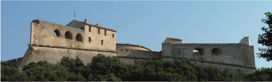
Figure 156 : Fort Carré vu du sud (cl. E. Guilloteau).
