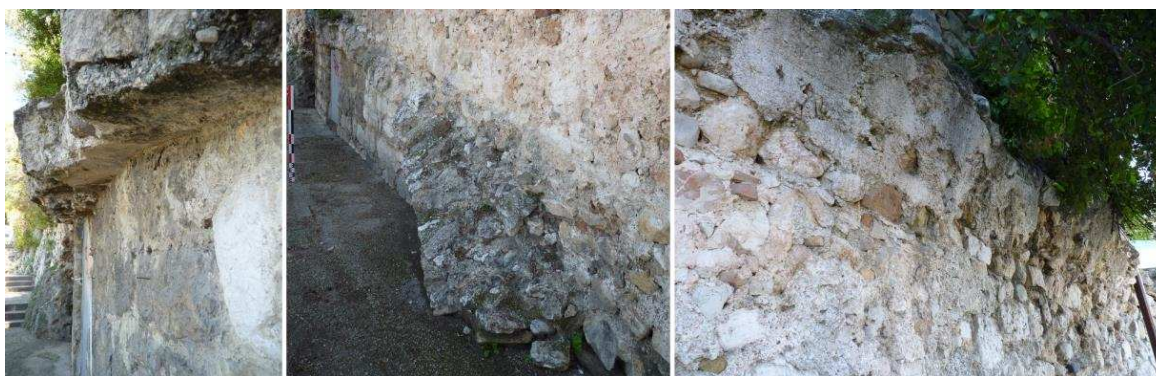
Figure 73 : Vestiges de la galerie pris dans les remontages contemporains (cl. E. Guilloteau).
