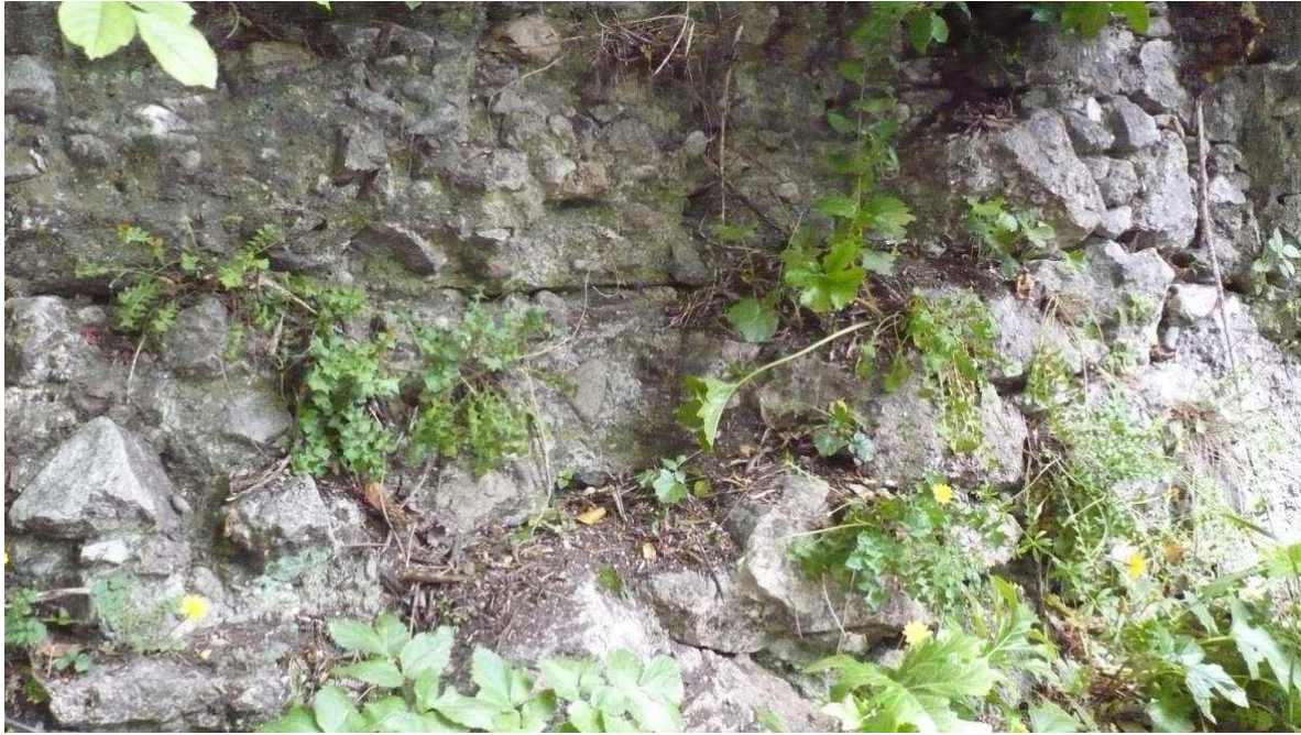
Figure 223 : Élément de parement de la fausse-braie (à droite) et de son blocage (à gauche) (cl. E. Guilloteau).
