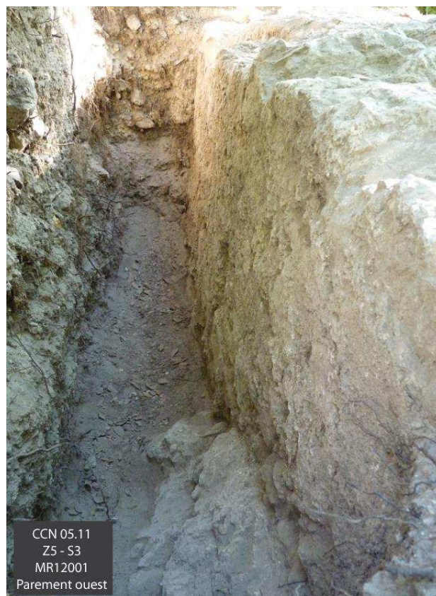
Figure 148 : Vue du parement ouest, contrescarpe du fossé (Cl. E. Guilloteau/SAVN).
