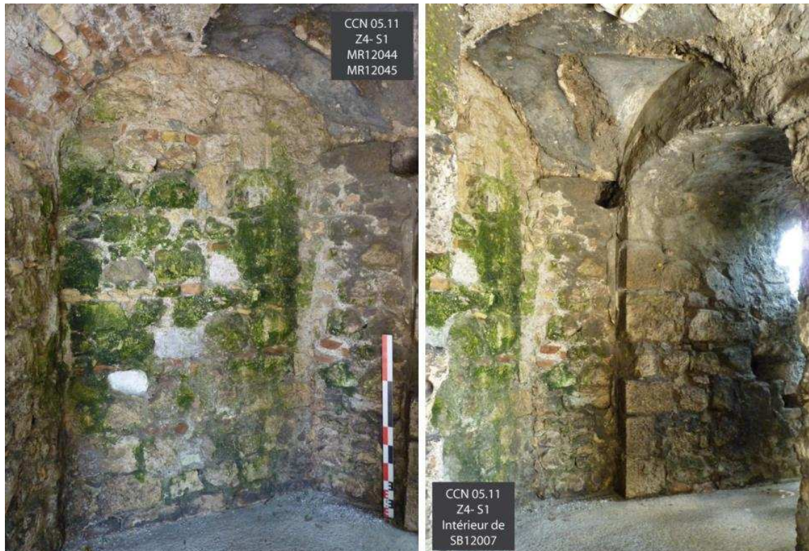
Figure 168 : Passage muré par MR12045 et vue d'une des voûtes d'arêtes (Cl. E. Guilloteau/SAVN).
