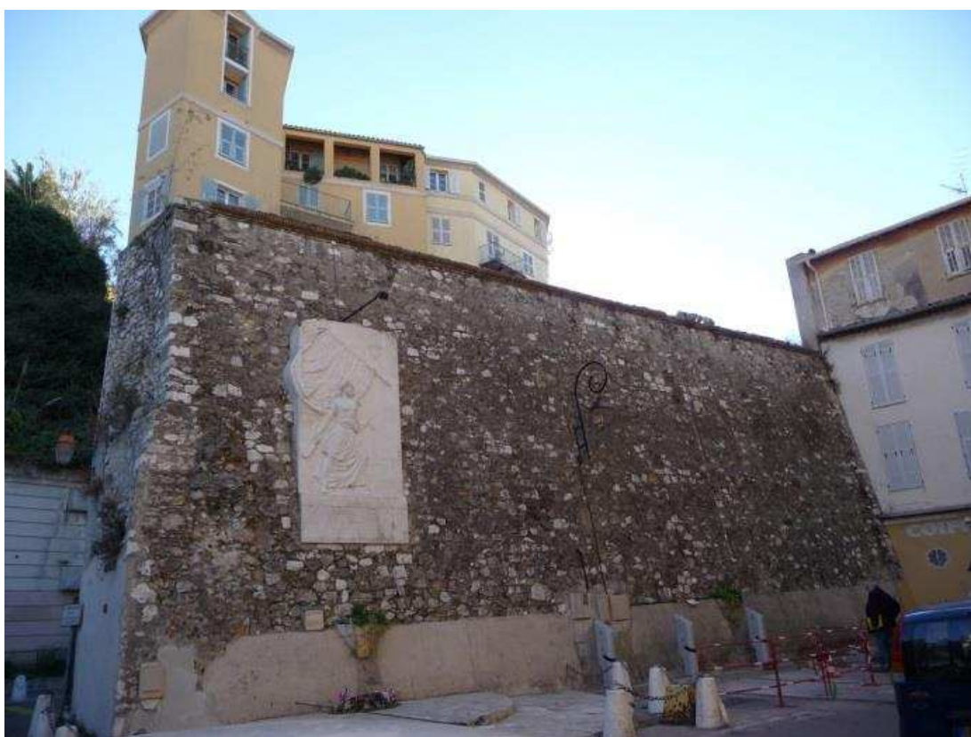
Figure 57 : Mur remanié, conservé au nord-ouest sur le tracé de l'enceinte du XIV e siècle (cl. Henri Geist).
