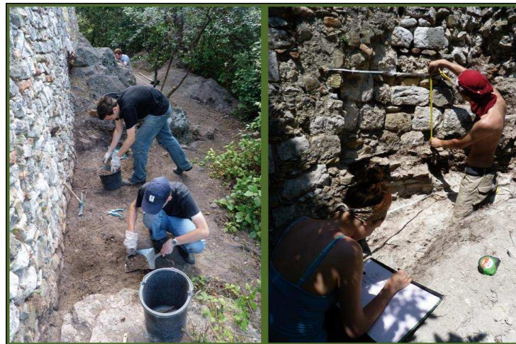
Figure 55 : Début des fouilles et relevés au niveau de la seconde enceinte sud du château comtal (Cl. E. Guilloteau/SAVN).
