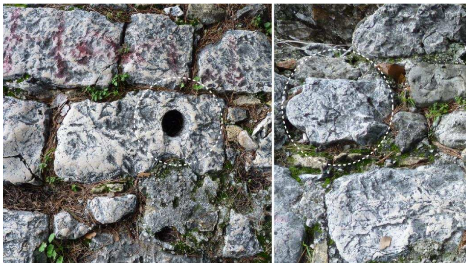
Figure 78 : Exemples de blocs en réemploi : ancien conduit d'évacuation et pied-droit (cl. E. Guilloteau)
