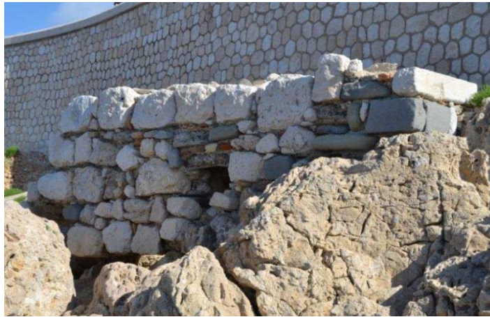
Figure 333 : Face méridionale du mur avec une chantepleure (cl. Stéphane Morabito/SAVN).
