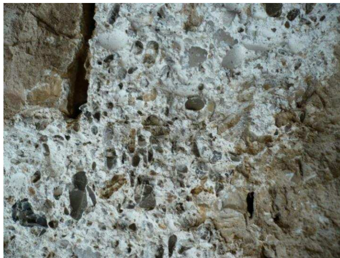
Figure 7 : Détail du mortier de chaux avec agrégat de petits galets (Cl. E. Guilloteau/SAVN).
