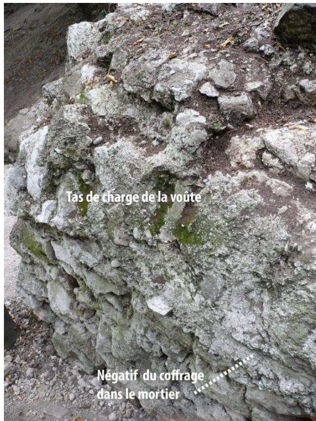
Figure 46 : Détail du vestige 21022, avec son départ de voûte et le négatif du coffrage (Cl. E. Guilloteau/SAVN).
