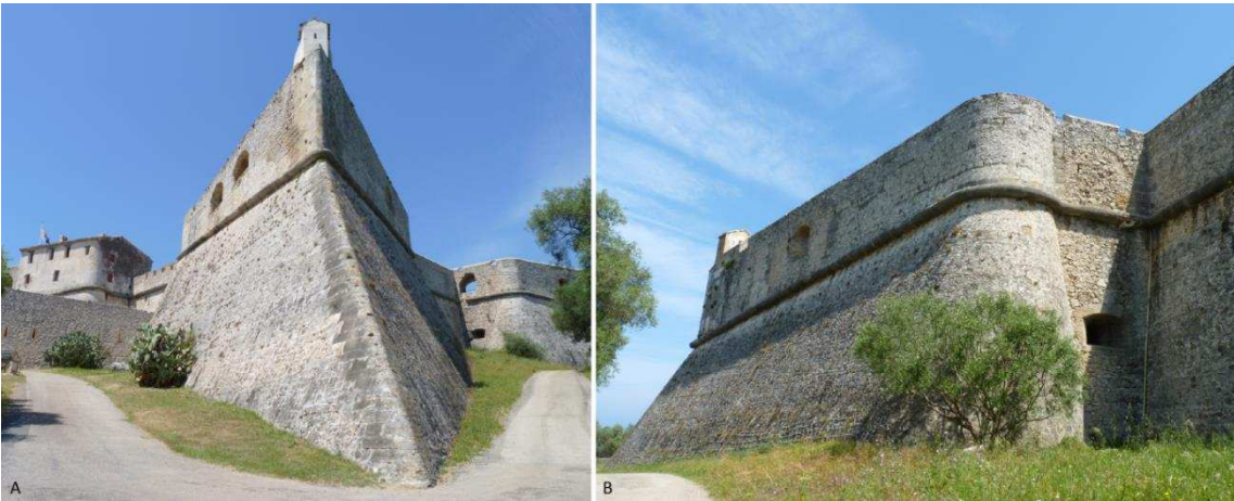
Figure 157 : Fort Carré - (A) Angle flanqué du bastion sud-ouest ; (B) Le flanc, l'orillon, et la grande face nord du bastion nord-est (cl. E. Guilloteau).
