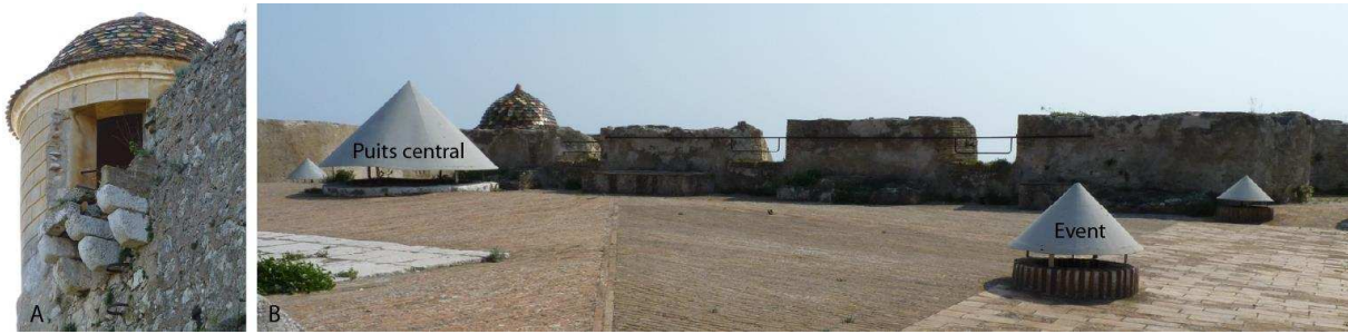
Figure 184 : (A) Vestiges des corbeaux soutenant les latrines, avec une échauguette en arrière-plan. (B) Plate-forme ou terrasse sommitale avec le large puits de lumière central et 3 événements (cl. E. Guilloteau).
