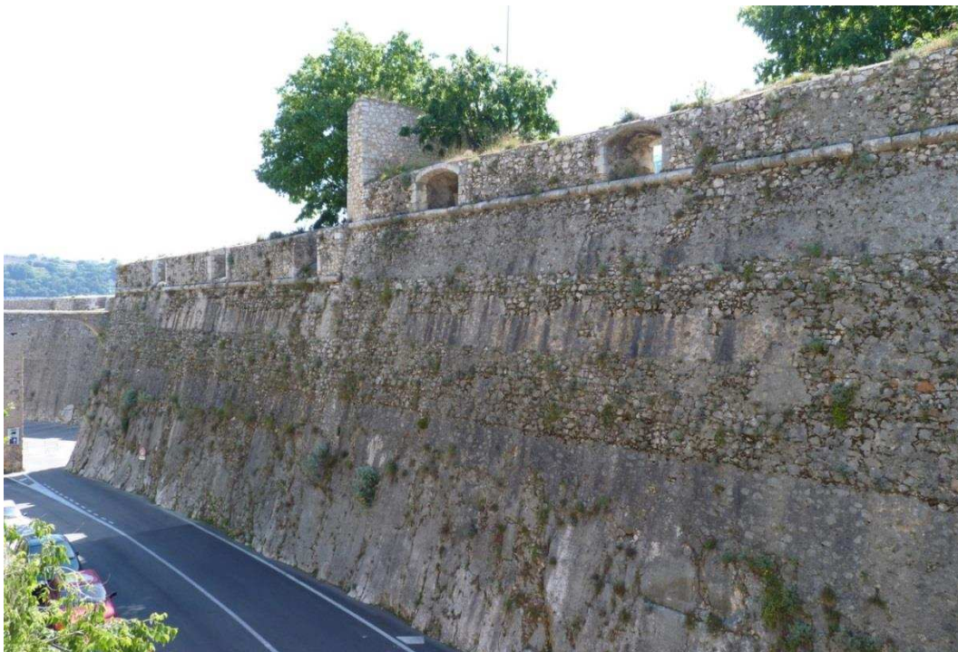
Figure 178 : Face nord du bastion nord-ouest où apparaissent nettement la maçonnerie banchée et le creusement du fossé dans la roche (cl. E. Guilloteau).
