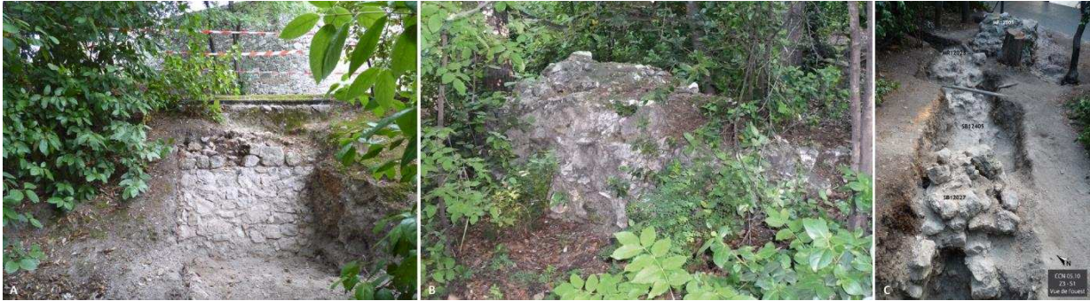
Figure 41 : Vestiges de la braie dans le contexte du parc : (A) MR12037 en cours de dégagement dans le talus sous le chemin montant vers le secteur du palais ; (B) Une partie de la courtine méridionale avant son dégagement ; (C) Vestige de la courtine sud après son dégagement partiel (cl. E. Guilloteau).
