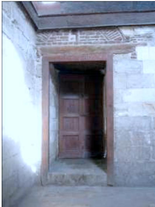
**Figure VI-11 Poutre taillée dans un tronc de palmier, installée comme linteau de porte à la chambre funéraire au Mausolée du sultan al-Nāṣir Muḥammad.**
