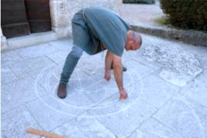
Figure VI-1 Pour tracer des cercles et des arcs sur le chantier on se sert d'une corde, d'une règle et d'une craie. Photos prises par © Jean-Noël Lippert<sup>3</sup>, lors d'une démonstration sur l'usage de la géométrie traditionnelle dans les bâtiments.
