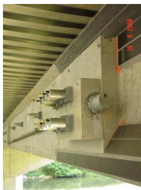
пр. 1 сн. 29: Усилване на съществуващи греди на мост, Le Mans (2005), Франция [SETRA, 2013]
