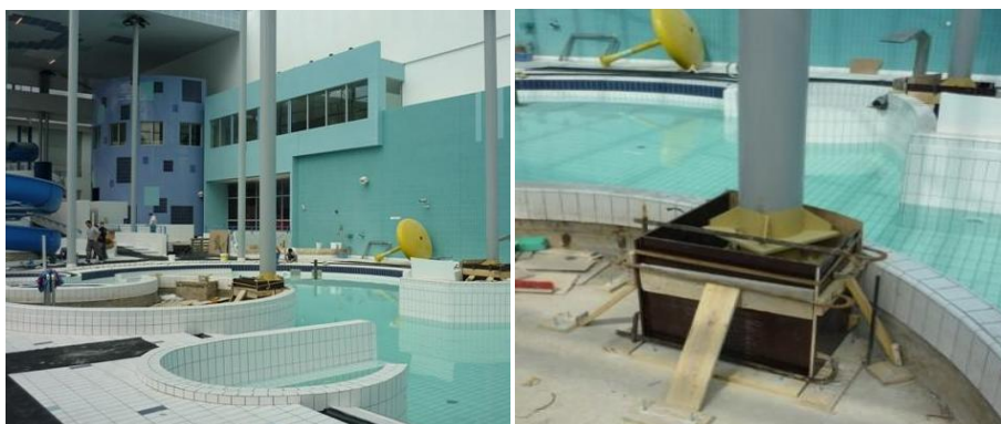
пр. 1 сн. 27: Възстановяване на стоманени колони подложени на химическа корозия (2009), Франция [www.ductal-lafarge.com]
