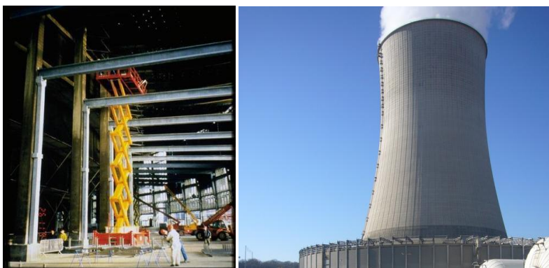
пр. 1 сн. 11: Греди и пласти на атомна централа: Cattenom nuclear power station (1999), Франция [Voort, 2008]
