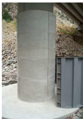
пр. 1 сн. 28: Усилване на устои на мостове, Valabres (2003), Франция [SETRA, 2013]
