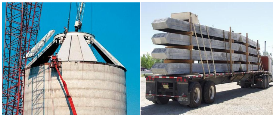
пр. 1 сн. 12: Покривни панели и греди на клинкерен силос: Clinker Silo Joppa (2011), САЩ [ www.ductal-lafarge.com ]
