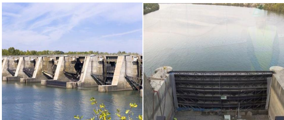
пр. 1 сн. 30: Възстановяване на язовирни стени подложени на абразивни въздействия: Caderousse (2009), Франция [www.ductal-lafarge.com]
