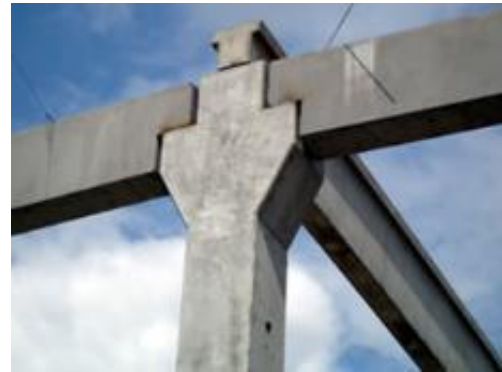
Figure 1-2: Console courte dans une construction d'habitation
