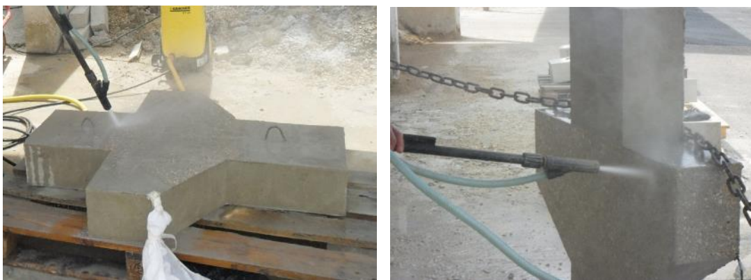
Figure 3-6 : Traitement de surface par sablage
