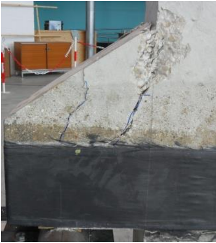
Figure 3-82: Rupture par compression
