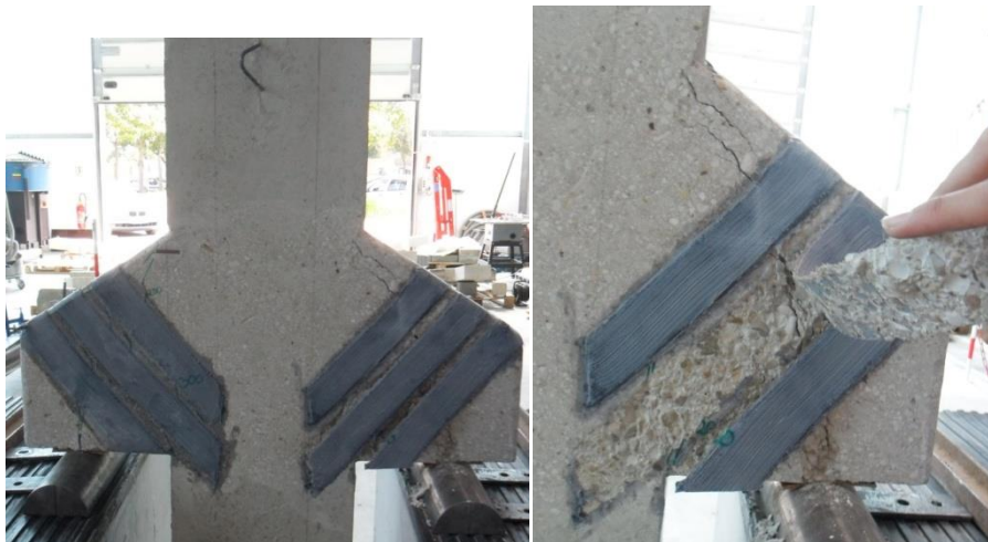
Figure 3-75 : Rupture de la console renforcée par bandes inclinées en forme de U des deux faces (CIU2b)
