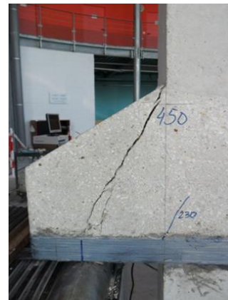
Figure 3-85: Rupture par fendage diagonal
