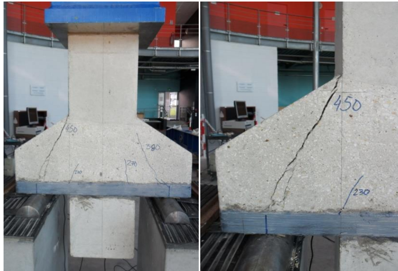
Figure 3-66 : Rupture de la console renforcée par bandage 3 couches unidirectionnelles et 5cm de largeur CB3u(5cm)
