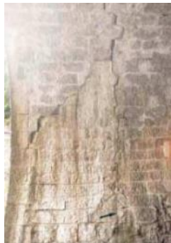
Figure 1-26 cas où la fissure suit les joints d'une maçonnerie sans traverser les moellons.
