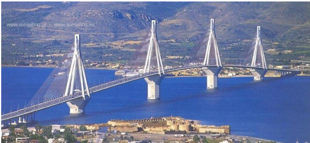
Figure 1-6 : Pont Rio-Antirion, en Grèce [photo prise sur internet]
