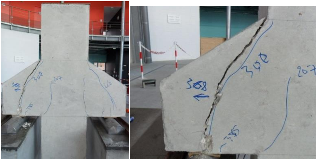
Figure 3-60 : Fissuration et rupture de la console de référence C0.
