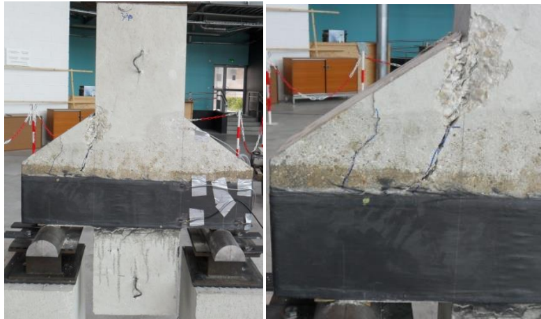
Figure 3-64 : Rupture de console renforcée par bandage, 5 couches unidirectionnelles - CB5u
