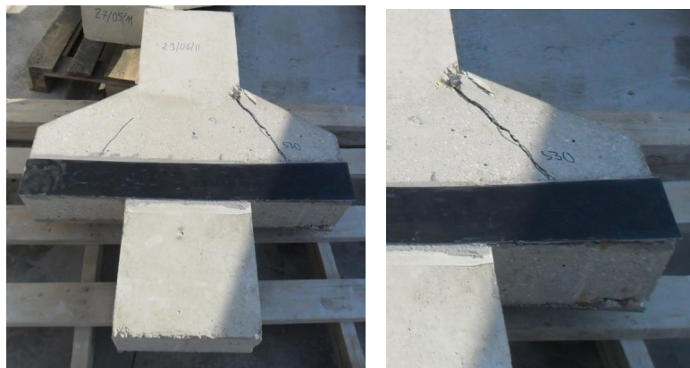
Figure 3-71 : Rupture de la console renforcée par plaque "CarboDur" sur les deux faces – CPC
