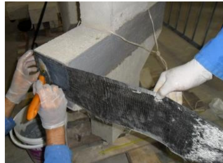
b) Application à l'aide d'un pinceau de la colle
