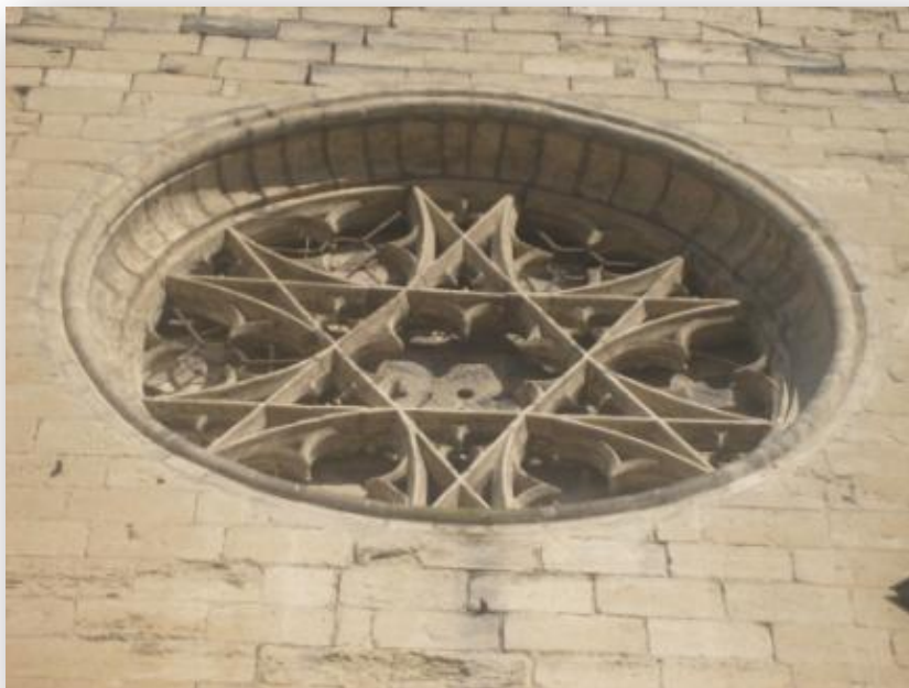
Figure 73 – Photographie de la rosace de la façade réelle à Avignon Crédit photographique : Wafa BOURKHIS.
