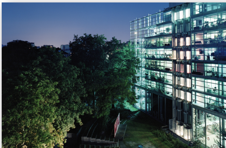
Figure 10 –L'espace de la Fondation Cartier à Paris (RL) 134
