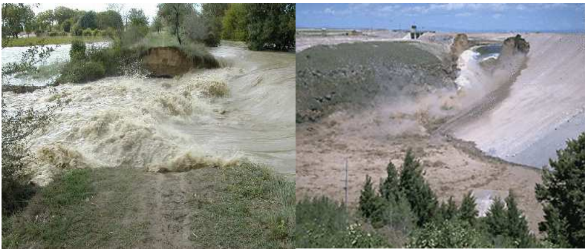
Figure 1.1. Brèche du Virdourle, 2002 (gauche) et rupture du barrage de Teton, 1976 (droite).
