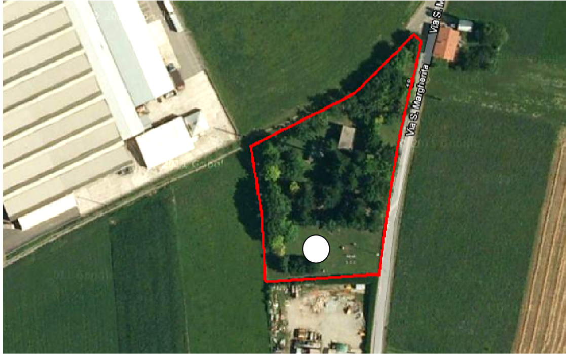
figure 4-23 : vue aérienne du site caractérisé.
