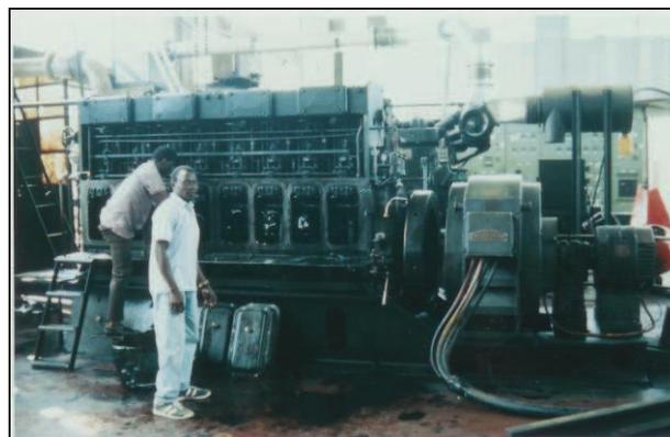
Photo 118. Générateur en nettoyage aux ateliers de Nampula. En août 1998 sur deux générateurs en place, un seul était en état de fonctionnement (photo 1998)
