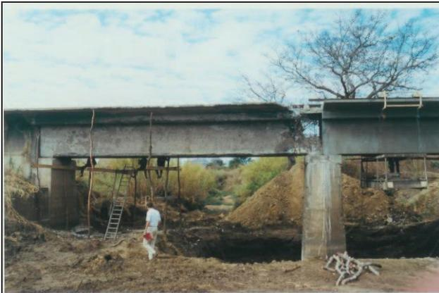
Photo 107. Le pont de Charogne. On voit en haut le trou béant au niveau du pilier (photo août 1998)
