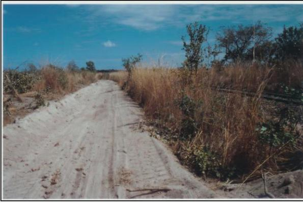
Photo 105. Le fossé de drainage des eaux pluviales réalisés le long de la voie entre Cuamba et Entrelagos par le Consorcio (photo août 1998)
