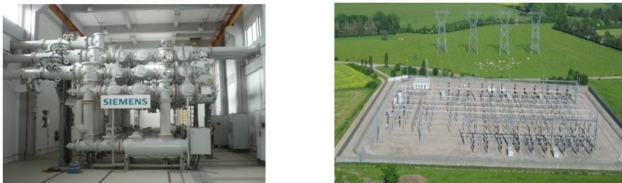
Figure 4 : Poste blindé (8DQ1 – 420 kV) Poste ouvert Houdreville (400 kV).
