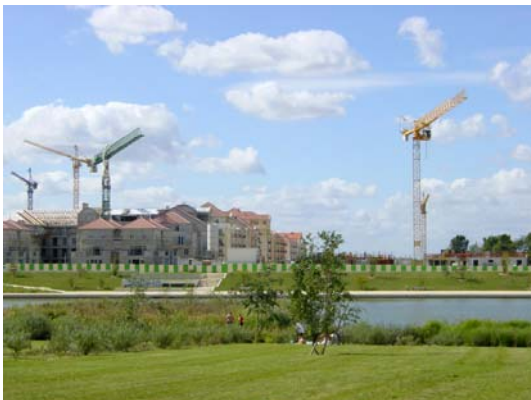
Photo 13 : Les chantiers et les grues de Bussy-Saint-Georges
