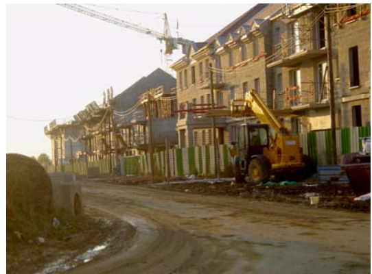
Photo 14 : Quartier en construction à Bussy-Saint-Georges
