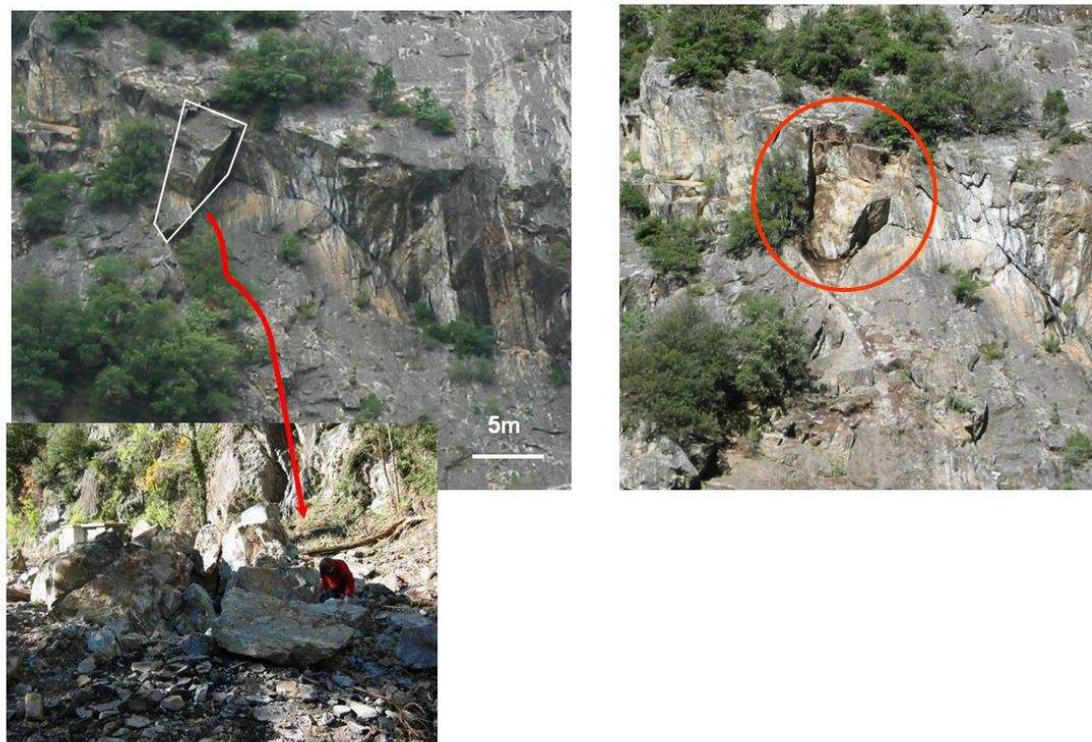
Figure 15 : Eboulement survenu en octobre 2004. En haut : Etat de la paroi avant (à gauche) et après (à droite) l'éboulement. En bas : Eboulis à hauteur des équipements hydroélectriques.
